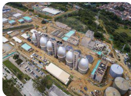
Plantas de tratamiento de agua residual – PTARs
