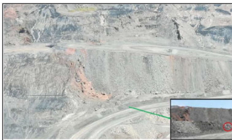
Figura 20. Rampa llegando al área caliente.
