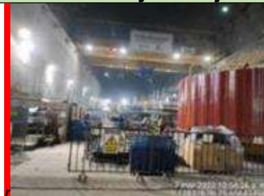
Fotografía 17 Caverna casa de máquinas sector sur – zona de maniobras y montajes
