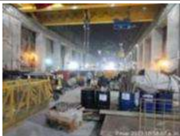
Fotografía 16 Caverna casa de máquinas sector norte
