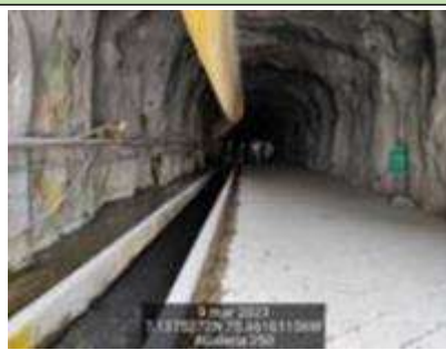
Fotografía 59 Acceso galería 250 y 313
