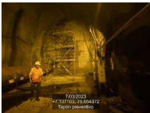
Fotografía 85 Tapón preventivo de la descarga intermedia
