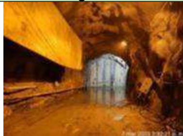
Fotografía 3 Tapón definitivo galería de acceso a descarga de fondo
