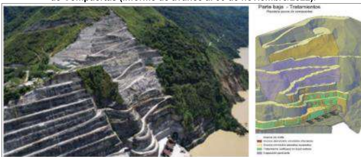
Figura 41 Avance en la excavación de la parte alta y baja de los taludes de la Plazoleta de Compuertas (Informe de avance al 30 de noviembre/2022).
