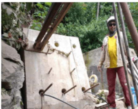
Puente Palestina. Perforación de dados de anclajes e instalación de anclajes
