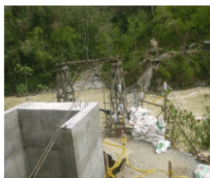
Puente Palestina. Vista pantalla (Estribo) margen derecha terminado
