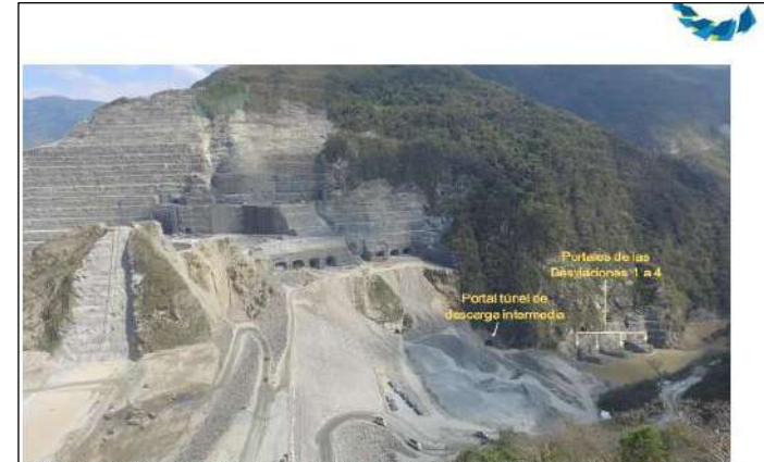
Figura 30. Registro fotográfico de talud del portal de la descarga intermedia previo al llenado no programado del embalse- Año 2017. Fuente: Consorcio Generación Ituango - CGI, 2022.
