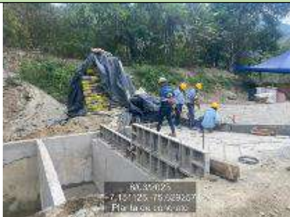
Fotografía 109 Planta construcción del sistema de recirculación de agua residual no doméstica
