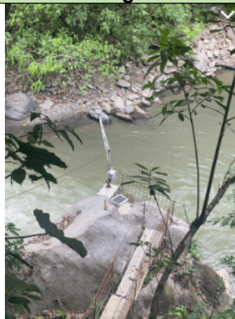
Fotografía 81 Estación hidrológica Rio Ituango nueva
