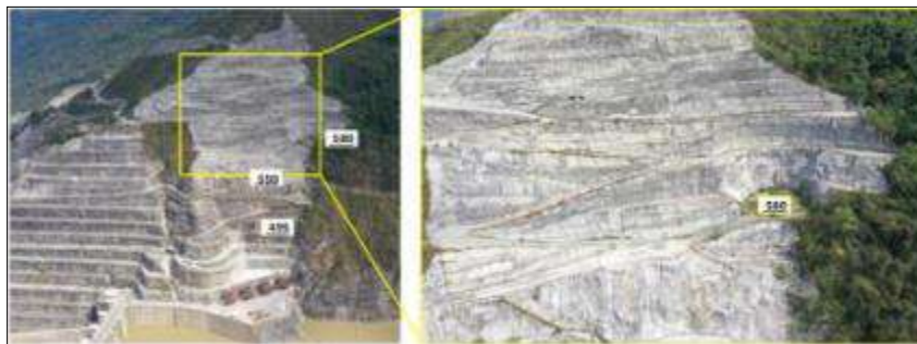
Figura 48 Taludes de la parte alta y baja de la Plazoleta de Pozos de Compuertas al 20 de enero/2023.
