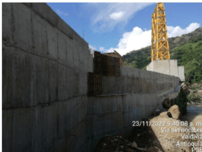
Imagen 5 Construcción muro de protección
