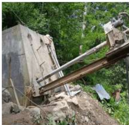
Puente Palestina: margen izquierdo río Cauca. Perforación de dados para instalación de anclajes
