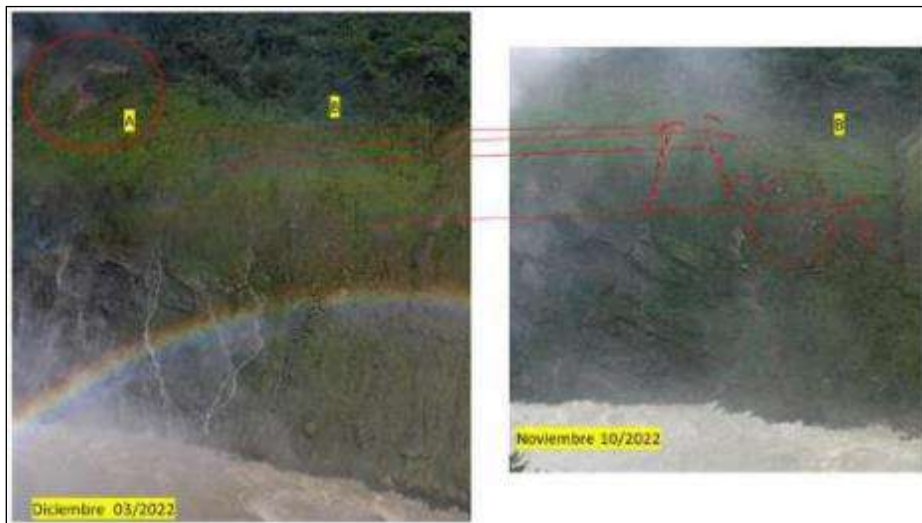
Figura 66 Sector B, analizado para los meses de noviembre y diciembre del 2022, además del detalle de los movimientos activos del sector A.
