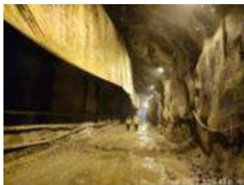
Fotografía 2 Galería de acceso a la descarga de fondo
