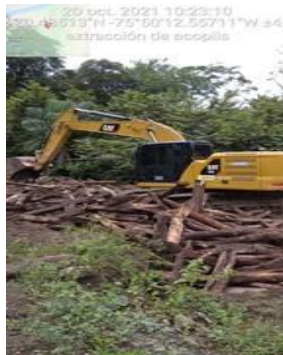
Acciones de compactación del material leñoso en el depósito Mameyes
