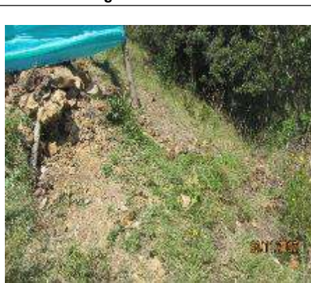
Fotografía 84. Torre 72 - RFPP de la Cuenca Alta del Río Bogotá- Afectación vegetación aledaña
