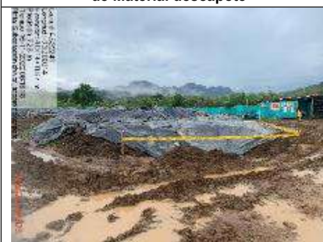
Fotografía 86. Subestación Chivor - Acopio de Material descapote
