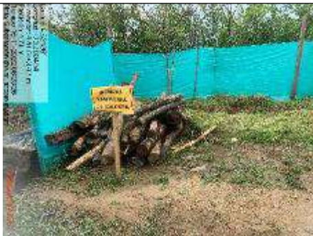
Fotografía 92. Subestación Chivor II – Acopio de madera, debidamente señalizado
