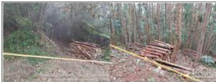
Fotografía 4. Acopio de material aprovechado. Fuente: J.E JAIMES Ingenieros S.A., 2022
