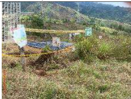
Fotografía 129. Torre 6 A- Reutilización y conformación con Material descapote
