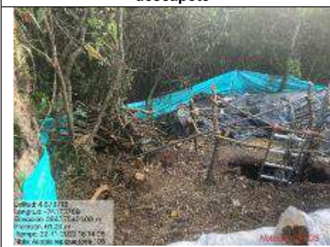
Fotografía 88. Torre 106- Acopio de Material descapote
