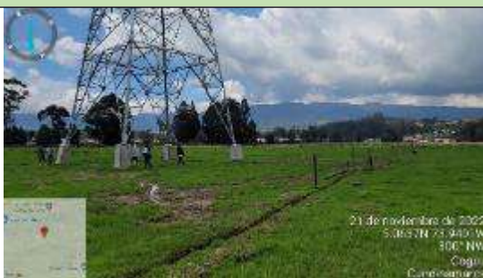
Fotografía 49 Torre 18, Ubicación de la torre en zona plana sin afectación de rondas hídricas coordenadas origen único, E 4895808.11 2117610.83
