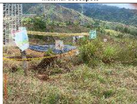
Fotografía 87. Torre 109NN - Acopio de Material descapote
