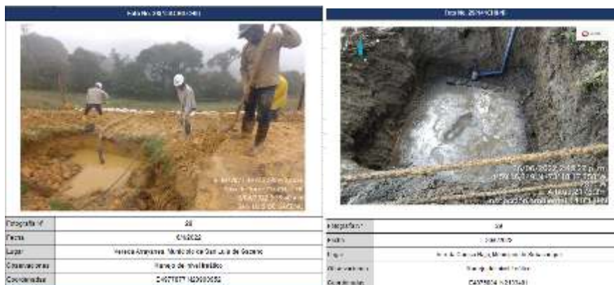
Bombeo de nivel freático durante construcción de torres
