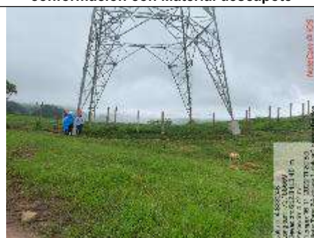
Fotografía 89. Torre 6 A- Reutilización y conformación con Material descapote
