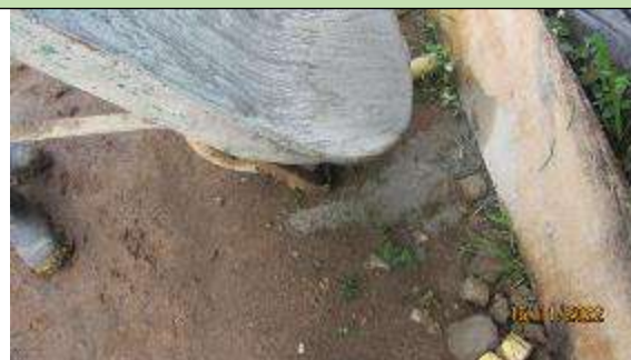
Fotografía 80. Carretillas con remanente de agua-concreto Subestación San Luis de Gaceno
