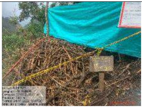
Fotografía 96. Torre 114NB – Acopio de repique de madera, debidamente señalizado y aislado.
