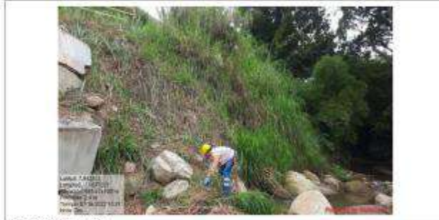
FOTOGRAFIA No: 01 FECHA: Julio de 2022 LUGAR: K0+000 OBSERVACIONES: Recuperación paisajística área previamente intervenida
