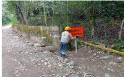
FOTOGRAFIA No. 07 FECHA: Mayo de 2022 LUGAR: Vía industrial 6 OBSERVACIONES: Señalización vial
