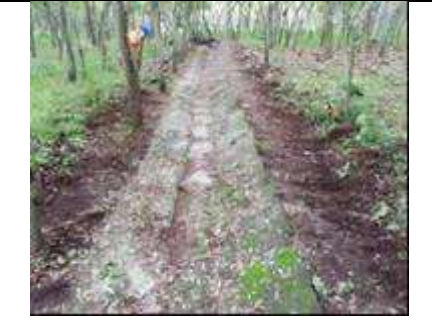
Fotografía. Limpieza cunetas en bolsacreto, retrolenado puzolana. Enero 2019.
