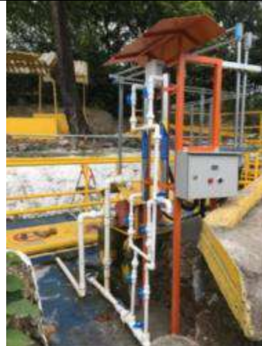
Fotografía. Montaje y funcionamiento de los filtros IV para el tratamiento de aguas residuales.
