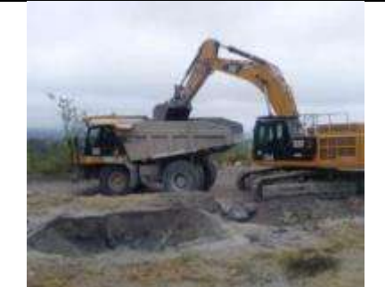
Fotografía. Maquinaria empleada en limpieza a sedimentador. Enero 2019
