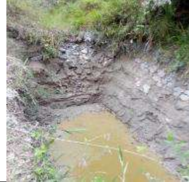
Fuente: ICA 25. Anexo 4 Soportes \ Ficha-02 – Drenaje \ 02 MTTO Cunetas- 1B \ 20210814 MTTO_Cunetas
