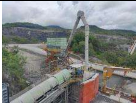
Fotografía Planta de trituración Secundaria. Mina La Esmeralda. 4766437.928E 2032958.283N MS(CTM12)
