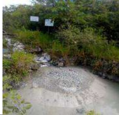
Fuente: ICA 25. Anexo 4 Soportes \ Ficha-02 – Drenaje \ 02 MTTO Cunetas \ 20210712 MTTO_Cunetas
