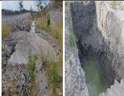
Fotografía. Limpieza a sedimentador (Antes - Después), mina La Esmeralda. Enero 2019
