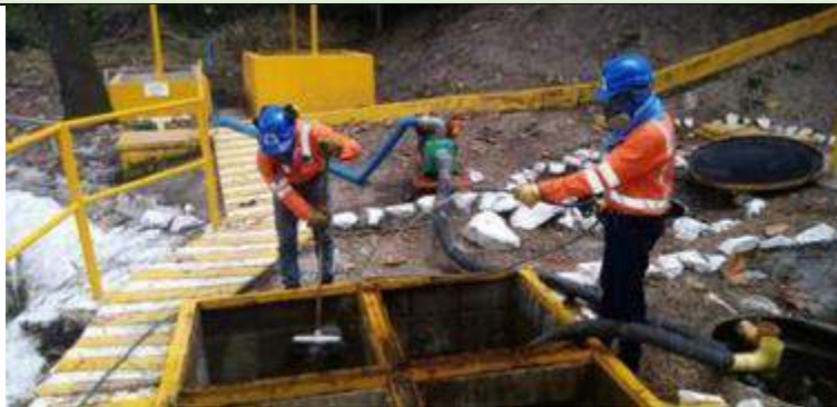
Fotografía. Limpieza de tanque de homogenización, sedimentador y filtros ascendentes
