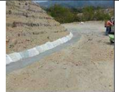
Fotografía. Construcción cuneta en concreto vía Escombrera Superior. Agosto 2019
