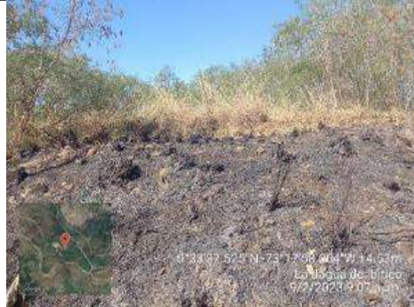
Fotografía 72. Evidencia de incendio en Botadero Sur. Coordenadas Origen Único Nacional (E 4967042 – N – 2614494)
