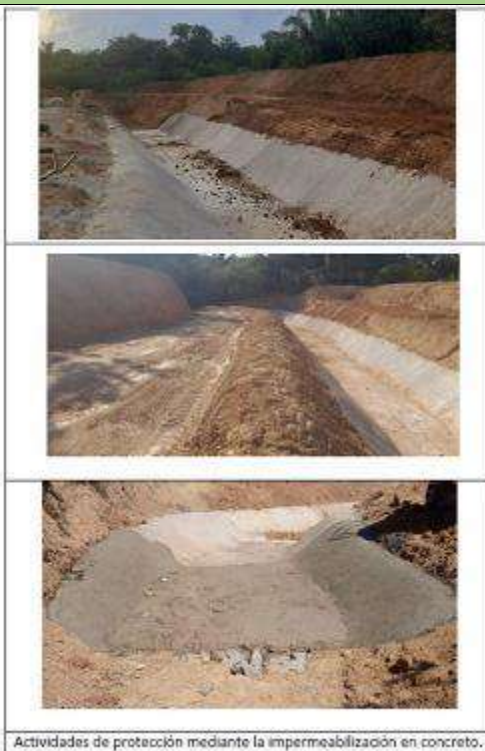
Actividades de protección mediante la impermeabilización en concreto.
