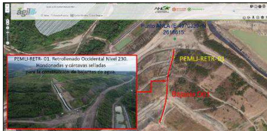
Figura 8. Ubicación de la Bajante D01 y del proceso erosivo PEMLJ-RETR-01. Retrollenado Occidental Nivel 230. Hondonadas y cárcavas selladas para la construcción de bajantes de agua. Fuente: Modificado – Equipo Seguimiento ANLA.
