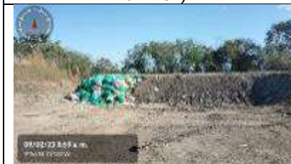
Fotografía 54. Celda activa relleno sanitario La Ceiba Coordenadas Origen Único Nacional (E: 4967075 – N: 2614482)
