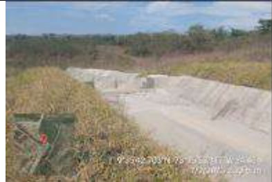
Fotografía 24. Canales de conducción a piscina León Coordenadas Origen Único Nacional (E 4971017- N 2618317)
