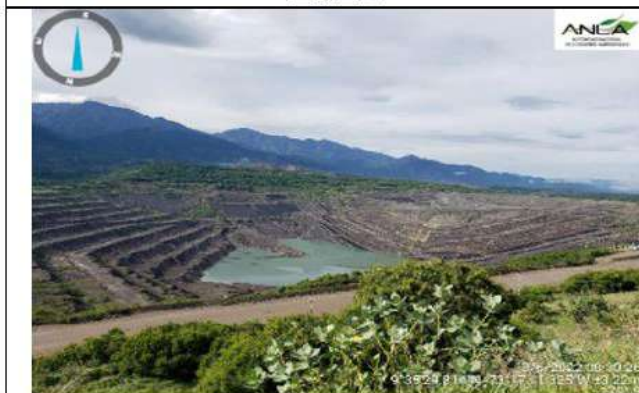
Fotografía 12. Panorámica sumidero Pit Norte junio de 2022
