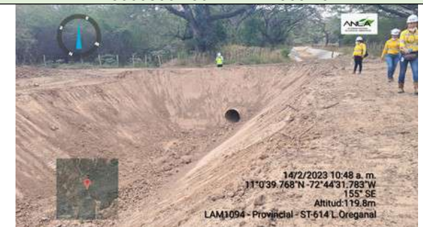
Fotografía 14. Canal antes del vertimiento, Coordenadas Magna Sirgas, origen Único E 5060806.436 - N 2777909.492
