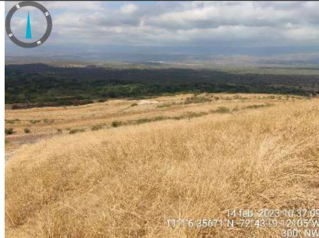
Fotografía 65. Estabilización taludes caras externas – Botadero 831 Coordenadas Magna Sirgas, origen Único E 5030358.17 - N 2775593.81
