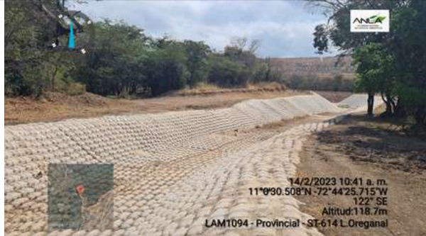
Fotografía 12. Canal de descarga Coordenadas Magna Sirgas, origen Único E 5060873.803- N 2776914.831
