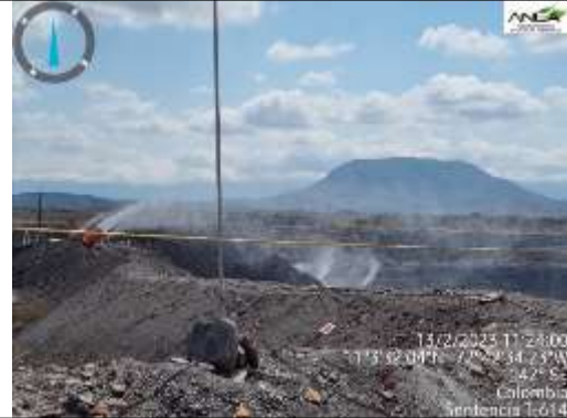
Fotografía 76. Operación de los cañones de niebla en Tajo Patilla (Zona Norte) Coordenadas Magna Sirgas, origen Único E 5031715.539 - N 2780067.808
