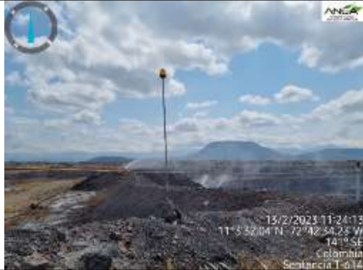
Fotografía 75. Operación de los cañones de niebla en Tajo Patilla (Zona Norte) Coordenadas Magna Sirgas, origen Único E 5031715.539 - N 2780067.808
