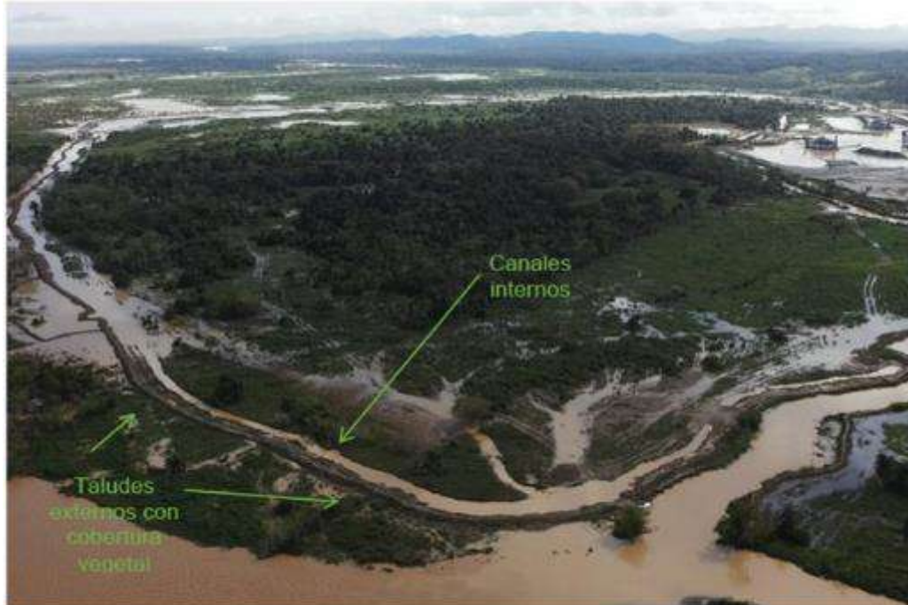
Figura 10. Canal interno en Jarillón perimetral y taludes con cobertura vegetal
