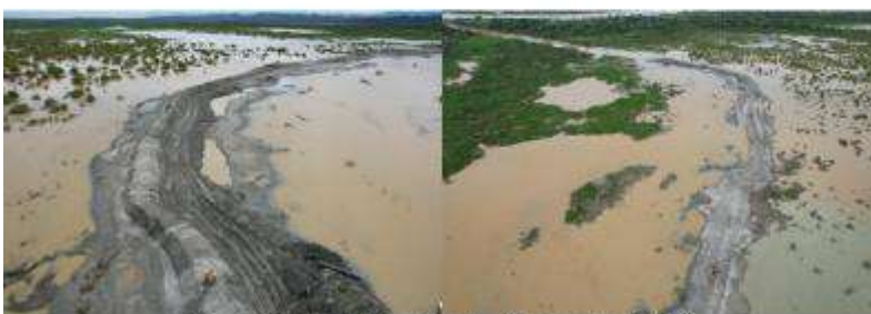
Construcción de jarillón Etapa 2 - 12 de agosto de 2022
