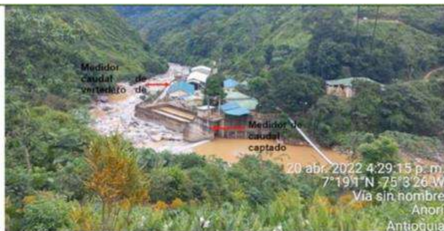
Figura 198. Superior izquierda Medidor de caudal captado en quebrada Sin Nombre Aljibes. Superior derecha: Medidor de caudal captado en quebrada Sin Nombre Campamento. Providencia I. Inferior: Medición de caudal captado en el río Anorí. Fuente: Información allegada por la Sociedad mediante radicado 2022094108-1-000 del 13 de mayo de 2022.
