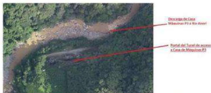
Fotografía 2 Vista aérea infraestructura Providencia III, 2022
