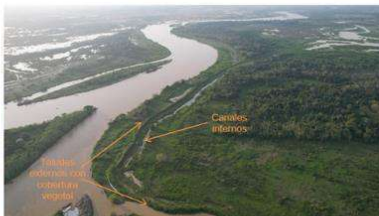
Fotografía 1 Canal interno en Janilón perimetral y taludes con cobertura vegetal Fuente: Mineros Aluvial S.A.S. BIC 2023
