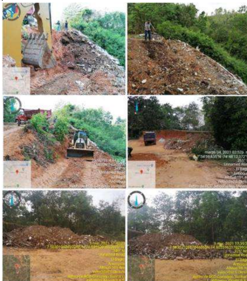
Figura 137. Excavación, retiro de la escombrera y acopio temporal de RCD. Fuente: radicado 2021210178-1-000 del 29 de septiembre de 2021.
