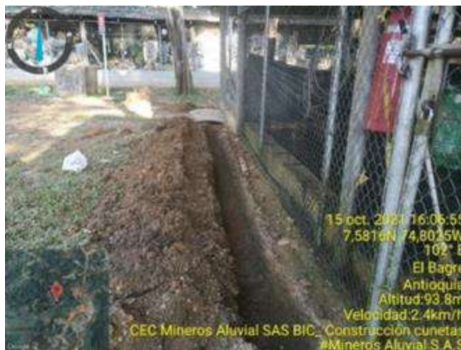
Figura 176. Construcción de cunetas para escorrentías, intervención civil perimetral centro de acopio de almacenamiento temporal de residuos peligrosos. Fuente: Respuestas de requerimientos Auto 11568 allegado por la Sociedad mediante radicado 2022073459-1-000 del 20 de abril de 2022.
