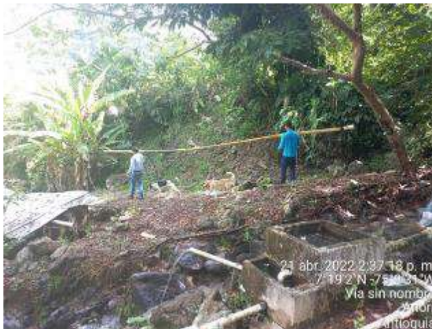
Figura 193. Retiro tubería de conexión directa existente del estanque de captación al desarenador derecho. Fuente: Información allegada por la Sociedad mediante radicado 2022088208-1-000 del 6 de mayo de 2022.
