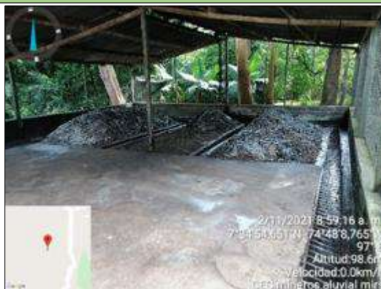
Figura 165. Cuneta perimetral en zona de compostaje. Fuente: Respuestas requerimientos Auto 11568 del 31 de diciembre de 2021, allegado por la Sociedad mediante radicado 2022073459-1-000 del 20 de abril de 2022.
