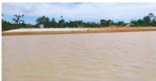
Fotografía 4 Estado actual planta de beneficio Llanuras PIT 250. Coordenadas planas origen único nacional: E: 4803522,81 y N: 2427293,15
