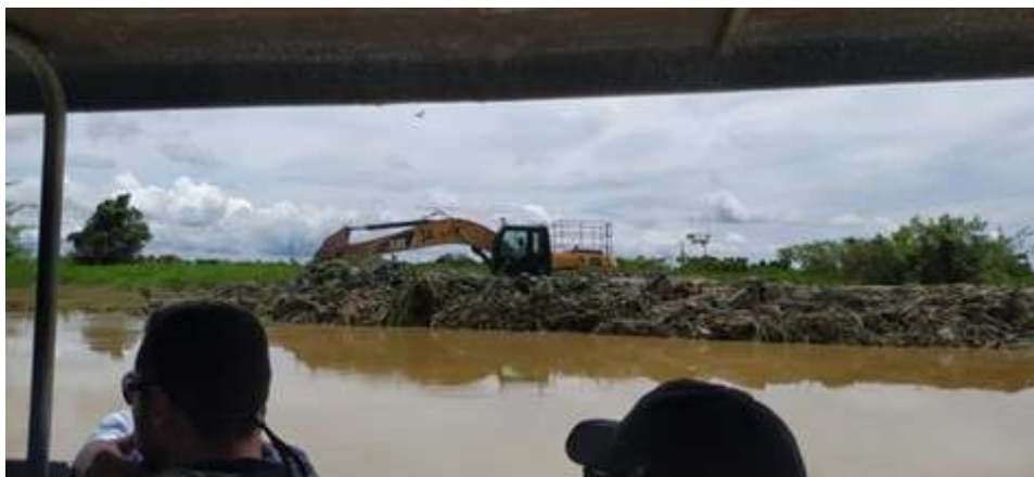
Figura 160. Conformación inicial del Jarillón perimetral del bloque CA5- Etapa 2 con material arcilloso. Fuente: Equipo Técnico de Seguimiento en visita de seguimiento llevada a cabo del 5 al 11 de julio de 2022.
