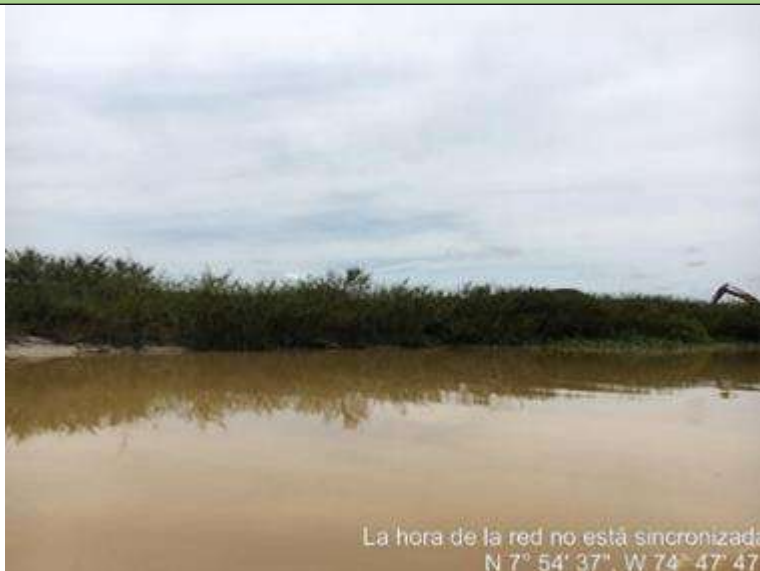
Figura 106. Avance de la recuperación de las márgenes del realineamiento del caño El Guamo. Fuente: Equipo Técnico de Seguimiento durante la visita de seguimiento llevada a cabo del 5 al 11 de julio de 2022.
