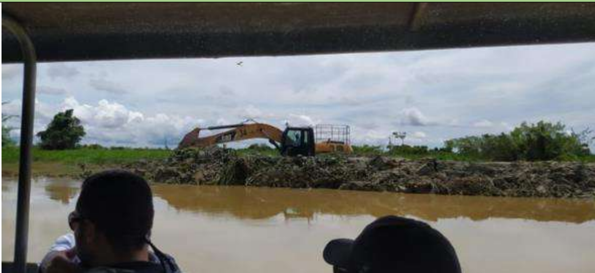
Figura 107. Conformación de Jarillón perimetral bloque CA5-Etapa 2, con material proveniente del proceso de descapote para conformación de poza. Fuente: Equipo Técnico de Seguimiento en visita de seguimiento llevada a cabo del 5 al 11 de julio de 2022.
