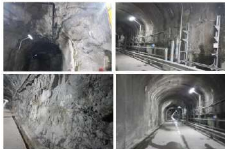
Fotografía 2. Inspección Túnel Casa de Máquinas 2021
