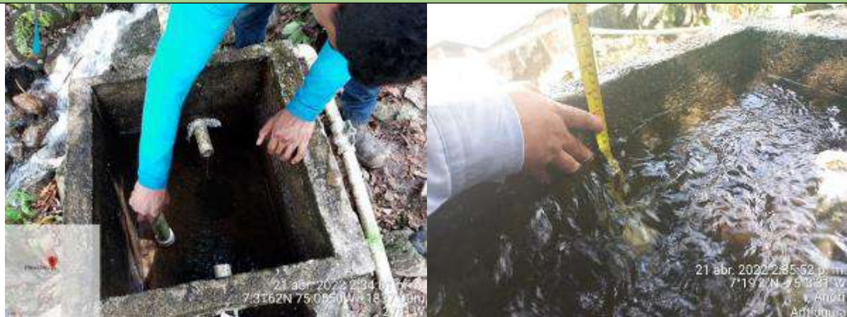
Figura 194. Acondicionamiento de tubería y ubicación a una profundidad máxima de 15 cm con respecto al rebose. Fuente: Información allegada por la Sociedad mediante radicado 2022088208-1-000 del 6 de mayo de 2022.
