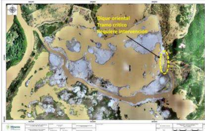
Figura 64. Tramo crítico del dique oriental PIT 320. Fuente: ICA 20, allegado por la Sociedad mediante radicado 2022131016-1-000 del 28 de junio de 2022.
