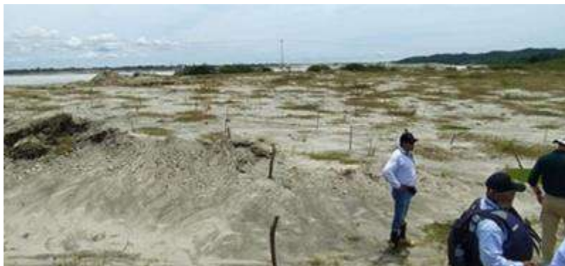
Figura 58. Perfilamiento de cargueros en el PIT 320 e inicio de revegetalización. Fuente: Equipo Técnico de Seguimiento durante la visita de seguimiento llevada a cabo del 5 al 11 de julio de 2022.
