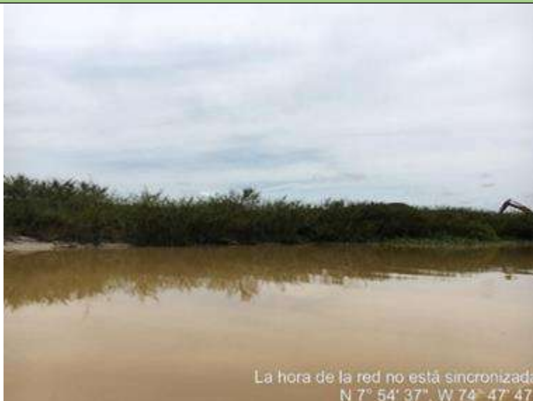
Figura 150. Avance de la recuperación de las márgenes del realineamiento del caño El Guamo. Fuente: Equipo Técnico de Seguimiento durante la visita de seguimiento llevada a cabo del 5 al 11 de julio de 2022.
