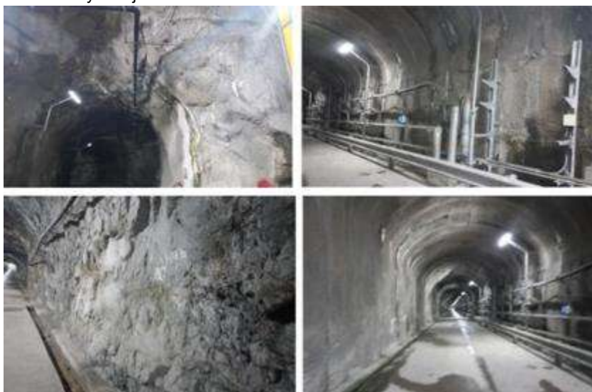
Figura 49. Túnel casa de máquinas en el año 2021. Fuente: ICA 20, allegado por la Sociedad mediante radicado 2022131016-1-000 del 28 de junio de 2022.
