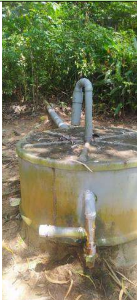
Figura 183. Pozo séptico en campamento bajo. Fuente: Equipo Técnico de Seguimiento durante la visita de seguimiento llevada a cabo del 5 al 11 de julio de 2022.
