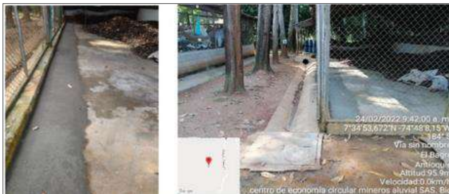
Figura 166. Izquierda: Reparación del piso de concreto de la celda de secado de compostaje. Derecha: Cunetas exteriores para el manejo de lixiviados. Fuente: Respuestas requerimientos Auto 11568 del 31 de diciembre de 2021, allegado por la Sociedad mediante radicado 2022073459-1-000 del 20 de abril de 2022.
