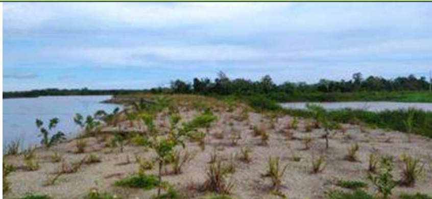
Figura 14. Jarillón Canchiro. Fuente: Informe construcción de Jarillón perimetral al sector Sampumoso, allegado por la Sociedad en el ICA 20 mediante radicado 2022131016-1-000 del 28 de junio de 2022.
