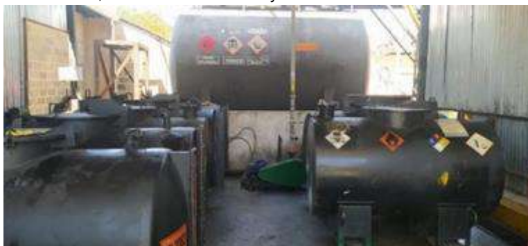
Figura 26. Tanque de almacenamiento de aceite usado. Fuente: Equipo de Seguimiento durante la vista de seguimiento llevada a cabo del 5 al 11 de julio de 2022.
