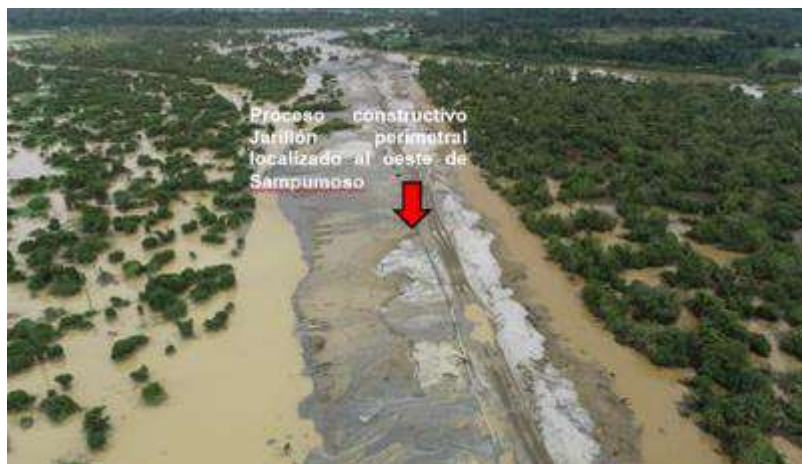
Figura 124. Jarillón perimetral al oeste del bloque Sumpumoso. Fuente: Informe allegado por la Sociedad mediante radicado 2022078135-1-000 del 26 de abril de 20202.
