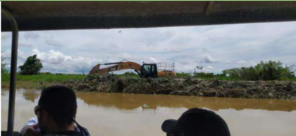
Figura 125. Conformación de Jarillón perimetral bloque CA5-Etapa 2, con material proveniente del proceso de descapote para conformación de poza. Fuente: Equipo Técnico de Seguimiento en visita de seguimiento llevada a cabo del 5 al 11 de julio de 2022.
