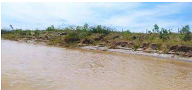
Figura 80. Avance de la recuperación de las márgenes del realineamiento del Nuevo Guamo. Fuente: Equipo Técnico de Seguimiento durante visita de seguimiento llevada a cabo del 5 al 11 de julio de 2022.
