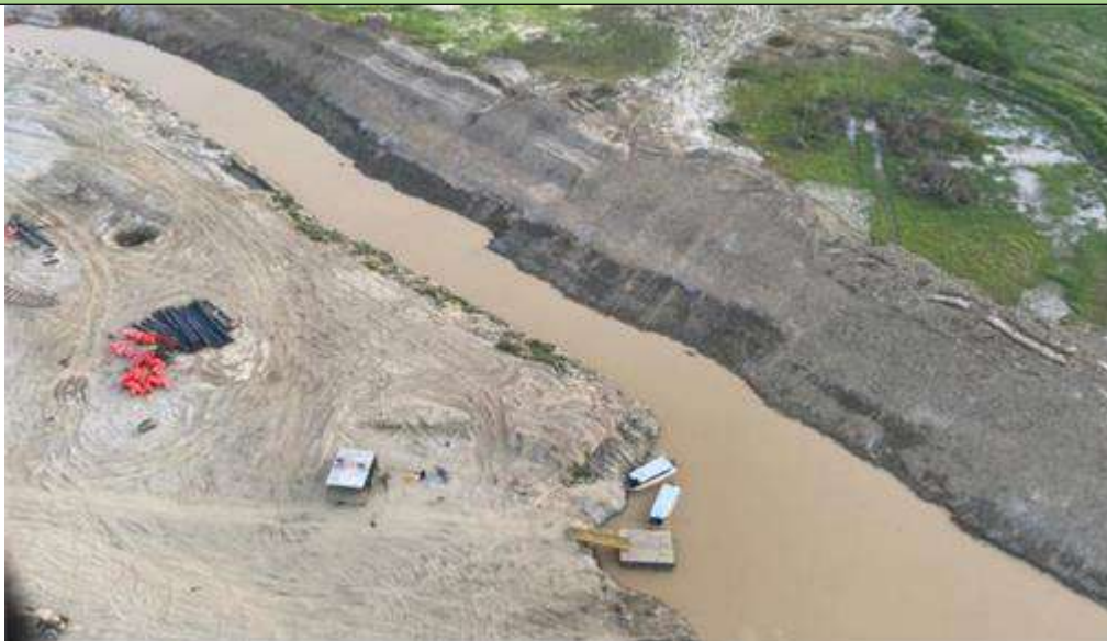
Figura 99. Márgenes realineamiento caño el Guamo. Fuente: radicado 2021240266-1-000 del 05 de noviembre de 2021.
