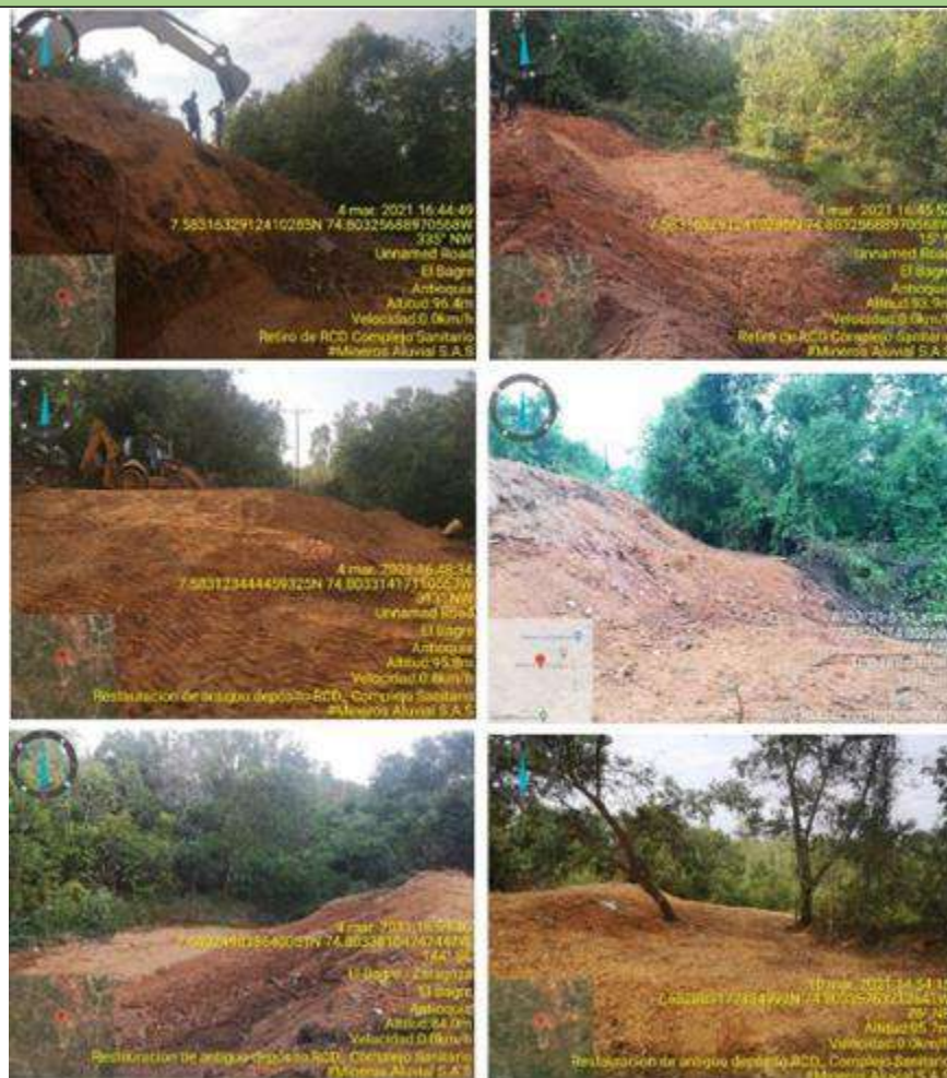
Figura 138. Reconformación morfológica de antiguo depósito de RCD. Fuente: radicado 2021210178-1-000 del 29 de septiembre de 2021.
