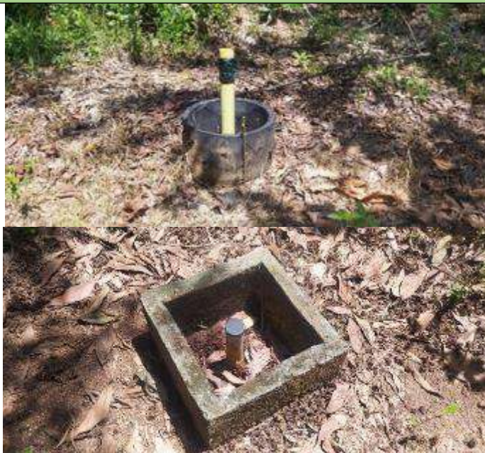
Figura 155. Piezómetros instalados en el Centro de Economía Circular para el monitoreo de aguas subterráneas como manejo de lixiviados. Fuente: Visita de seguimiento llevada a cabo del 5 al 11 de julio de 2022.
