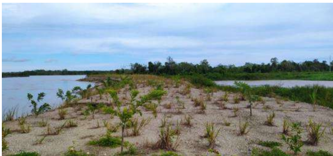
Figura 162. Revegetalización de jarillón contingencia Canchiro. Fuente: Equipo Técnico de Seguimiento en visita de seguimiento llevada a cabo del 5 al 11 de julio de 2022.
