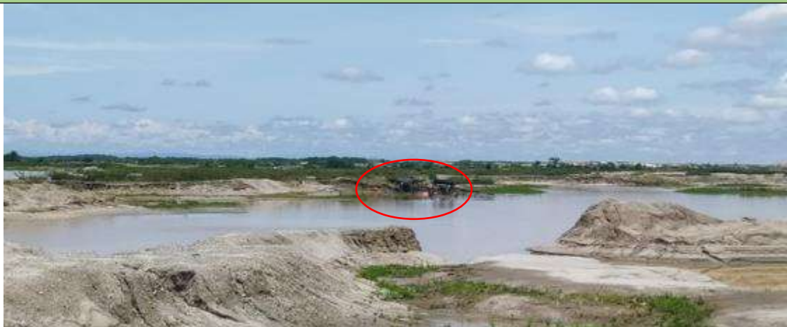
Figura 161. Dragas no autorizadas interviniendo jarillón perimetral de poza cerrada sobre el caño El Guamo. Fuente: Equipo Técnico de Seguimiento en visita de seguimiento llevada a cabo del 5 al 11 de julio de 2022.
