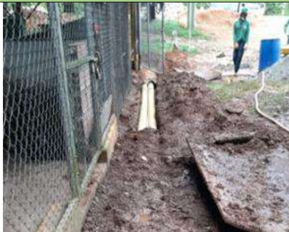
Figura 177. Instalación de tuberías subterránea y rellenado de zanjas, zona frontal del acopio temporal de almacenamiento de Respel. Fuente: Respuestas de requerimientos Auto 11568 allegado por la Sociedad mediante radicado 2022073459-1-000 del 20 de abril de 2022.
