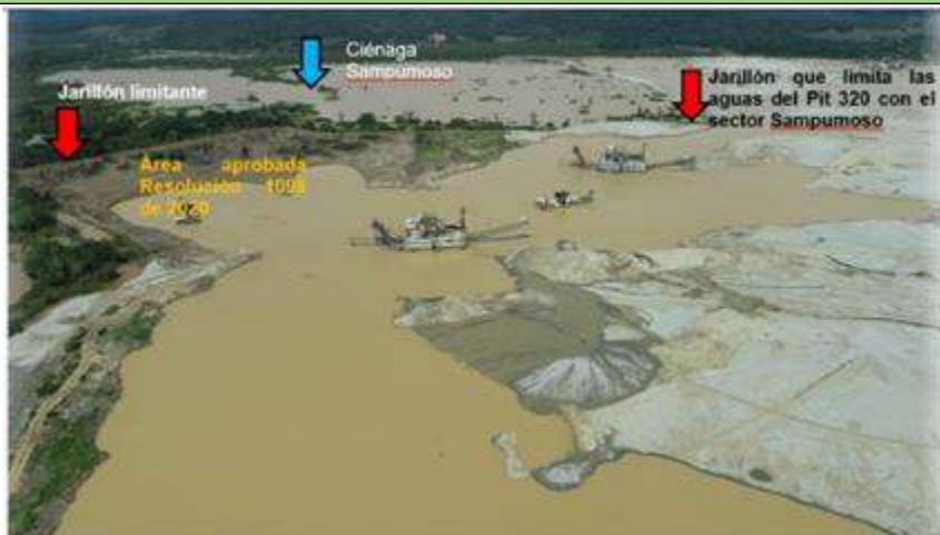
Figura 13. Jarillón perimetral bloque Sampumoso y áreas de operación. Fuente: Informe construcción de Jarillón perimetral al sector Sampumoso, allegado por la Sociedad en el ICA 20 mediante radicado 2022131016-1-000 del 28 de junio de 2022.
