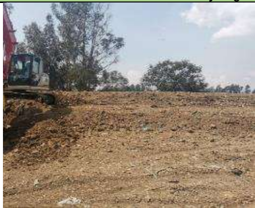
Fecha: 25 de julio de 2022 Lugar: Celda 3 – Predio la Magdalena Observación: Perfilamiento de la Celda 3
