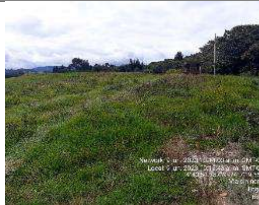
Fuente: Equipo de Seguimiento Ambiental ANLA, 9/06/2023
