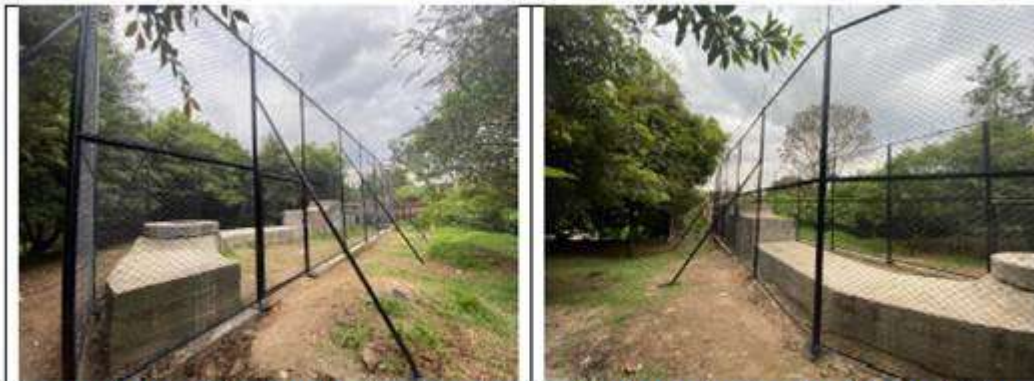
Cerramiento realizado a la estructura de conexión de la estación elevadora de Lisboa con la PTAR El Salitre, área común de la barrera ambiental 5 y 6 de la PTAR El Salitre
