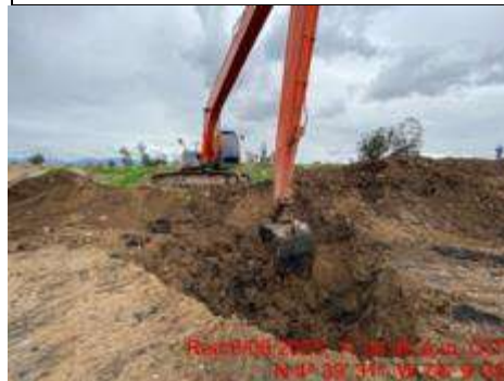
Fotografía 80. Proceso de mezcla suelo-biosólido- predio La Magdalena
