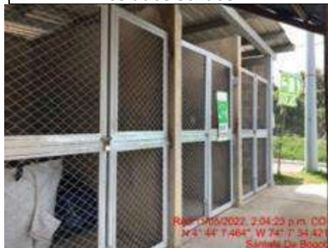
Fotografía 105. Bodega de selección y almacenamiento temporal de los residuos sólidos
