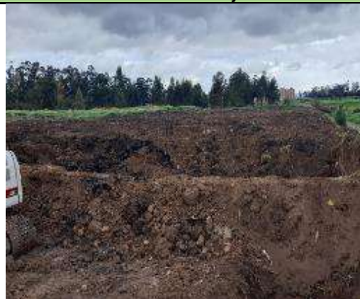
Fecha: 29 de julio de 2022 Lugar: Celda 3 – Predio la Magdalena Observación: Perfilamiento de la Celda 3
