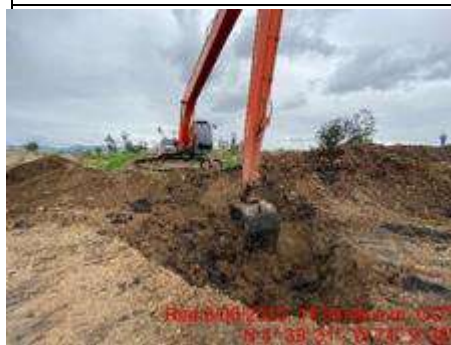
Fotografía 153. Proceso de mezcla suelo-biosólido- predio la Magdalena
