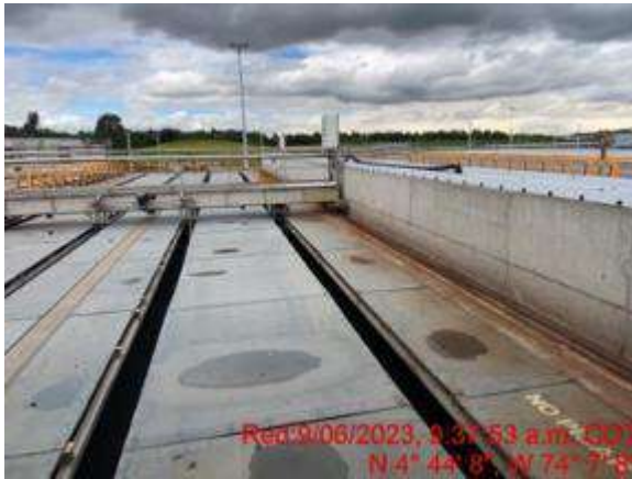
Fuente: Equipo de Seguimiento Ambiental ANLA, 9/06/2023
