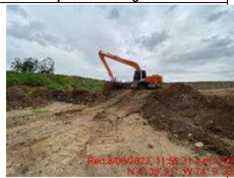
Fotografía 81. Disposición del material en la celda diaria (celda 11)-predio La Magdalena
