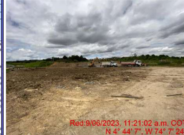
Fotografía 1. Proceso de desmantelamiento del área de campamentos
