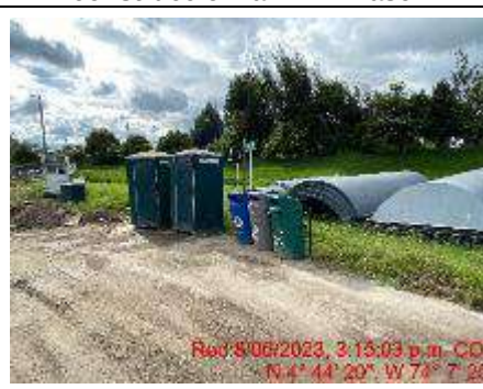
Fotografía 106. Recipientes de manejo de los residuos sólidos en el área de construcción la PTAR Fase I.
