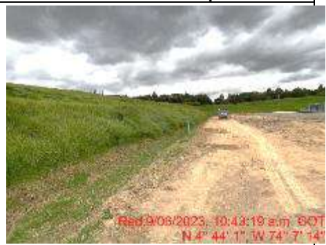
Fotografía 90. Características actuales de los aludes conformados sobre el costado sur de la planta
