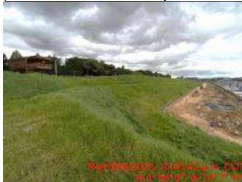
Fotografía 89. Estado actual de los taludes conformados sobre el costado suroccidental de la planta
