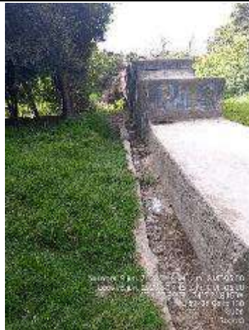
Fuente: Equipo de Seguimiento Ambiental ANLA, 8/06/2023
