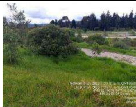
Fuente: Equipo de Seguimiento Ambiental ANLA, 9/06/2023
