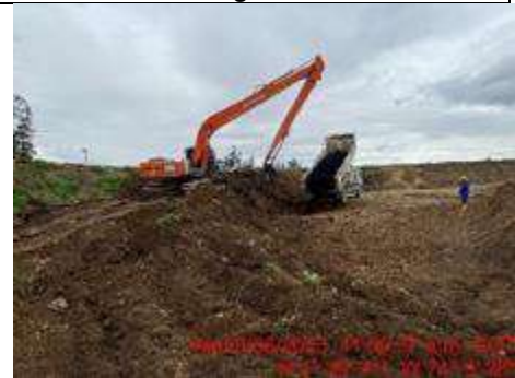
Fotografía 154. Disposición del material en la celda diaria (celda 11)- predio La Magdalena
