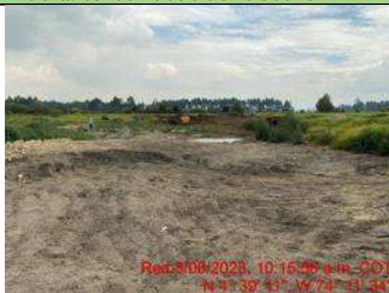
Fuente: Equipo de Seguimiento Ambiental ANLA, 8/06/2023
