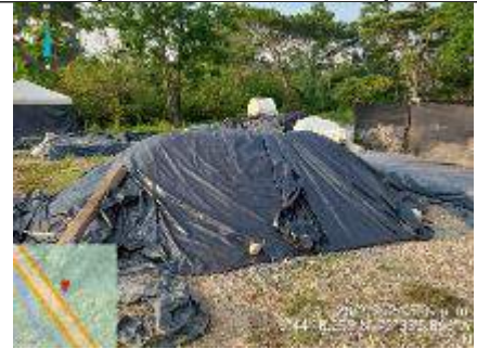
Fotografía A-01-01-F04-6. Almacenamiento de materiales de construcción – Patio Rancho Grande Coordenadas Origen Único Nacional (E 4939062 – N 2302638)
