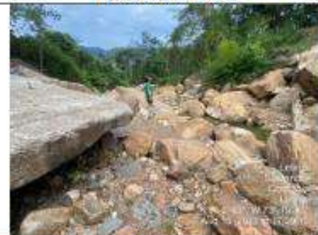
Estado actual del puente de paso sobre la Quebrada la Leona
