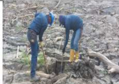
Apertura de hoyo para disposición final
