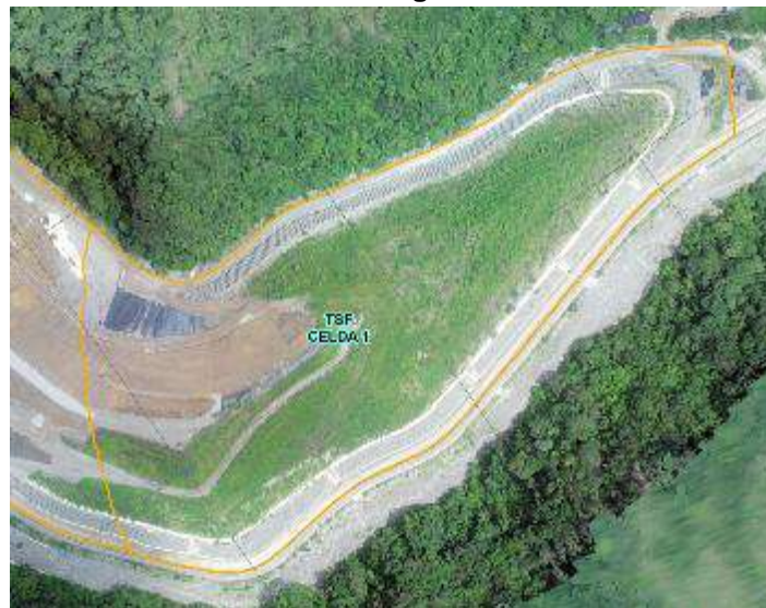
Figura PMA 7 – 01. Estado de la vegetación en la Celda 1 de la TSF
