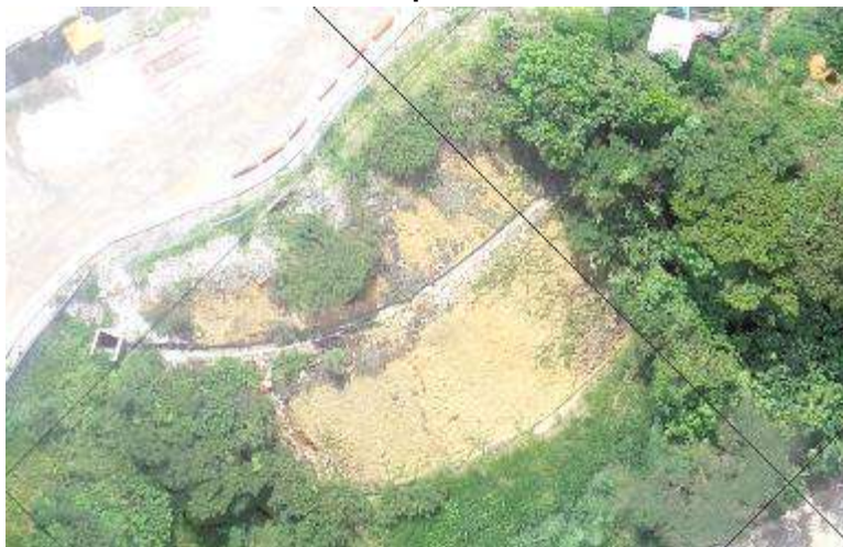
Figura PMA 13 – 21. Estado de ladera en parte del depósito de estériles en el sector de Rampa Sur.
