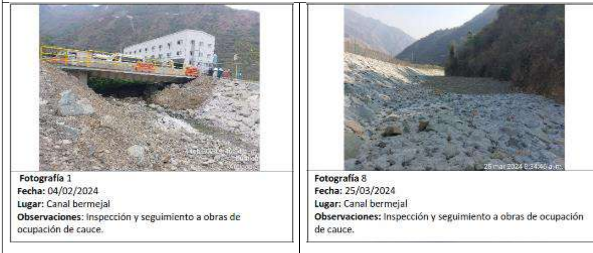
Figura 4. Inspecciones Obras de ocupación de cauce – Canal Bermejál
