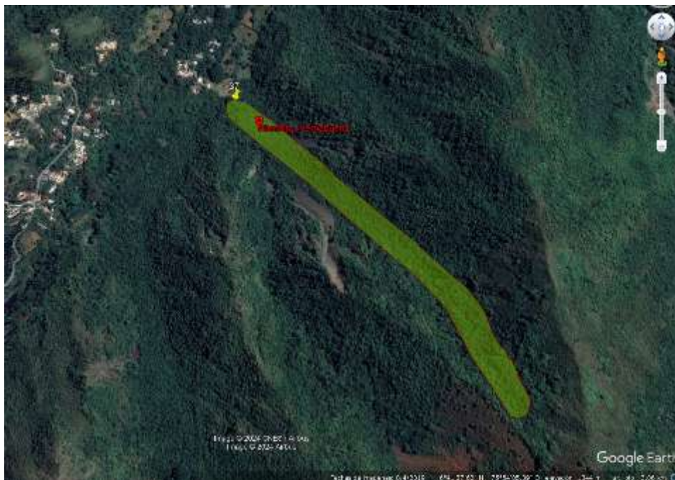
Fuente: Elaboración ESA ANLA con información del radicado 20246200856902 del 29 de julio de 2024. Visualizado en Google Earth.
