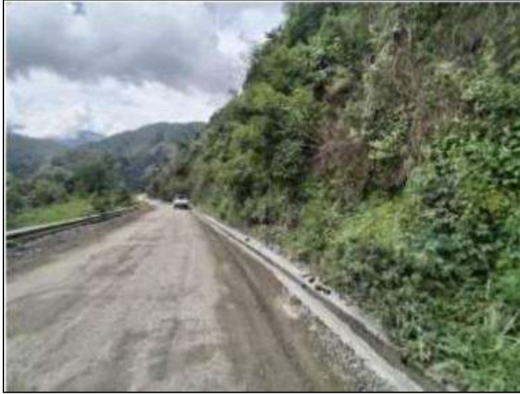
Figura PMA 13 – 16. Talud 2+100 - Jun 2024.
