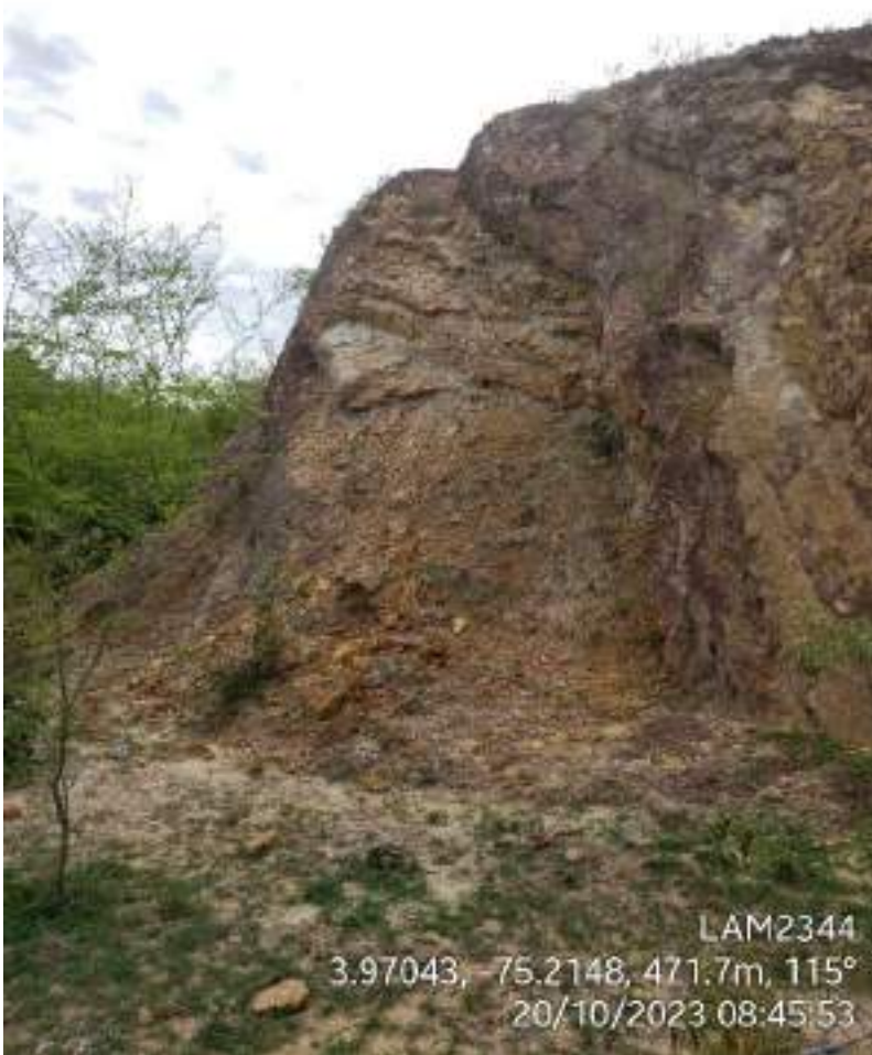
Fotografía 78. Vía de acceso plataforma Don Pedro CPI. Talud de corte con desprendimiento de material. Nótese la acumulación de fragmentos de roca y sedimentos en la pata del talud. Coordenadas Origen Único Nacional – E: 4754177 N: 1997064.
