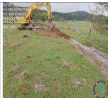
Fotografía No. 36 Fecha: 30-08-2021 Lugar: Ortega Sur 2 Observación: Demolición de la cunetas perimetrales, para la recuperación ambiental de la locación
