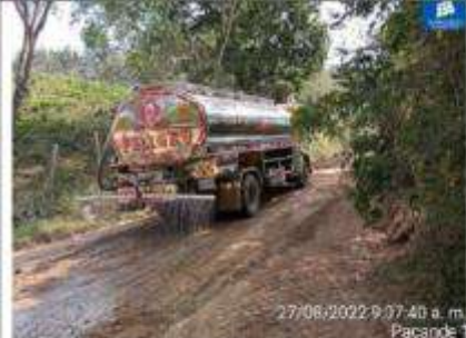
Fotografía No. 35 Fecha: 27/08/2022 Lugar: Campo Pacandé - San Luis Observación: Impacción y/o humectación de vía
