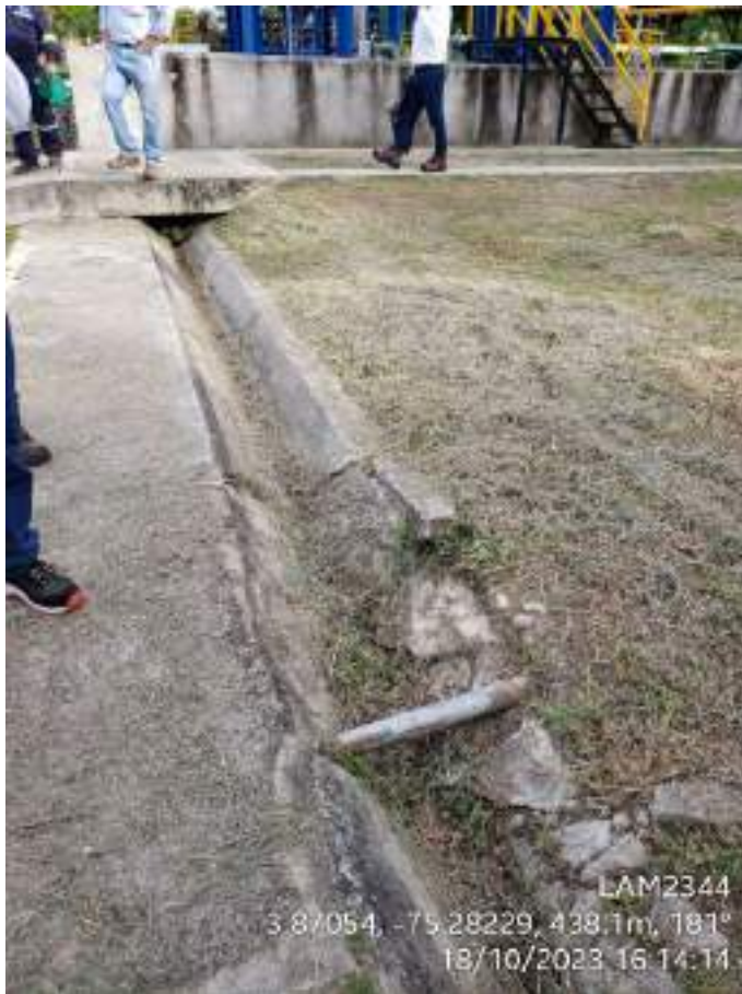
Fotografía 143. Estación Toldado. Cuneta perimetral para el manejo de agua lluvia ubicada cerca del área del manifold. Nótese la estructura fracturada. Coordenadas Origen Único Nacional – E: 4746644 N: 1986043.
