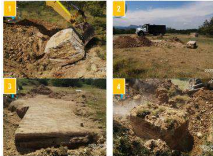
Foto 01 a la 04. Registro fotográfico retiro de escombros de la locación pozo Ortega 12.
