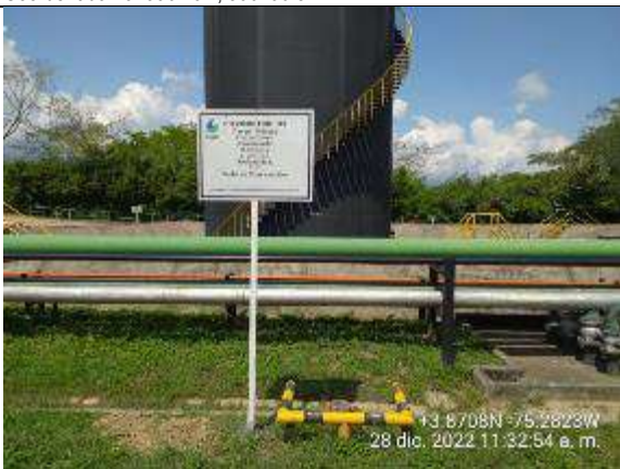
Fotografía No. Fecha: 29-12-2022 Lugar: Estación Toldado Observación: instalación de la señalización Piezómetro: #2 Estación Toldado
