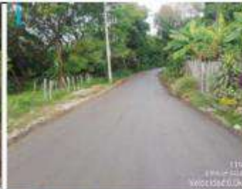
Fotografía 12. Lugar: Vía Campo Tóy Fecha: Agosto de 2022 Observación: mantenimiento de vía con emulsión asfáltica
