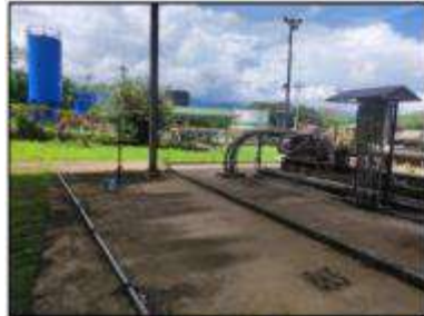
ER3: Planta de Inyección de Agua API Toldado
