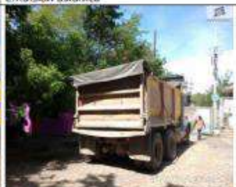
Fotografía 14. Lugar: Estación Toldado Fecha: Mayo 2022 Observación: Recubrimiento con geotextil los materiales de construcción durante el transporte al sitio de disposición.
