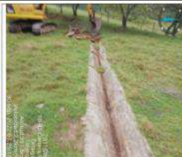
Fotografía No. 35 Fecha: 30-08-2021 Lugar: Ortega Sur 2 Observación: Demolición de la cunetas perimetrales, para la recuperación ambiental de la locación
