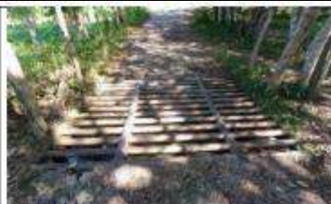
Fotografía 6. Lugar: Quiébralas vía Toldado 3 Fecha: Febrero de 2023 Observación: Quebra patas vía Toldado 3, libre de materiales sobrantes
