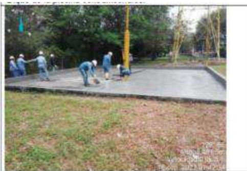
Fotografía #: 34 Fecha: septiembre 2022 Lugar: Estación Santa Rita Observación: Reparación de las fracturas del piso del dique de la tea.
