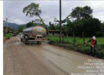
Fotografía No. 36 Fecha: 05-07-2022 Lugar: Campo Toy Observación: Irrigación de vía
