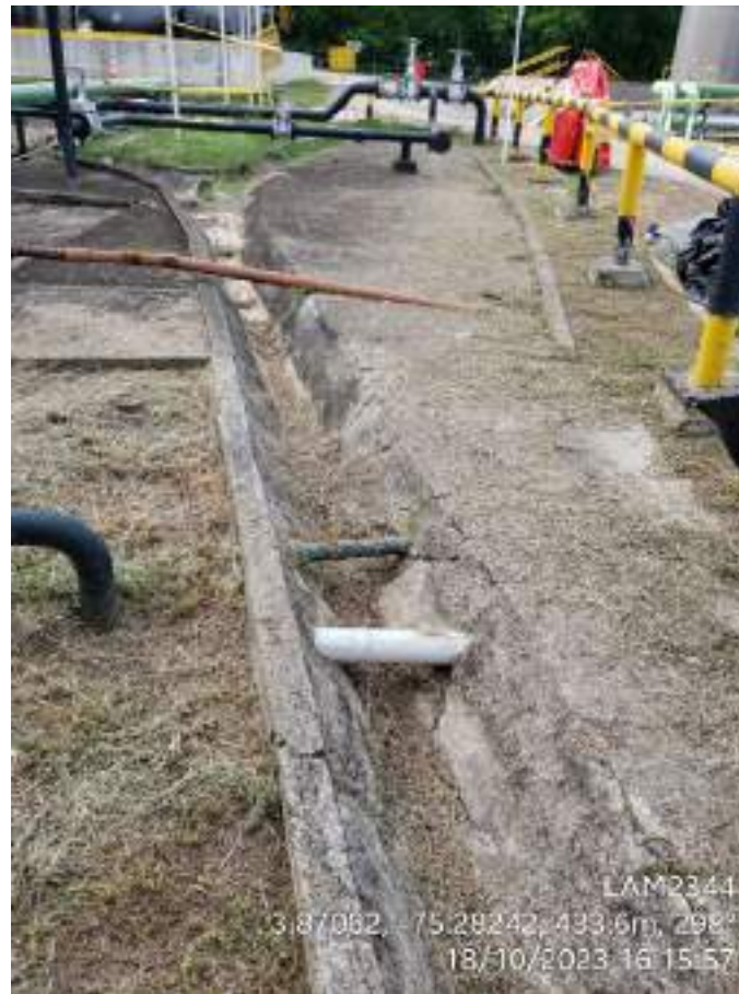
Fotografía 143. Estación Toldado. Cuneta perimetral para el manejo de agua lluvia ubicada cerca del área del manifold. Nótese la estructura fracturada. Coordenadas Origen Único Nacional – E: 4746644 N: 1986043.
