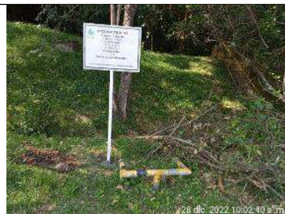
Fotografía No. Fecha: 29-12-2022 Lugar: Estación Toldado Observación: instalación de la señalización del Piezómetro: #1 Estación Toldado Coordenada: 919791.6N, 866099.3E
