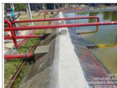
Fotografía #: 30 Fecha: septiembre 2022 Lugar: Estación Santa Rita Observación: Corona del dique de la piscina contraincendios-reparado.
