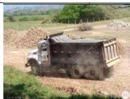
Fotografía No. 38 Fecha: 13-10-2022 Lugar: Pozo Ortega sur 2 Observación: sistema de carpado de volquetas.
