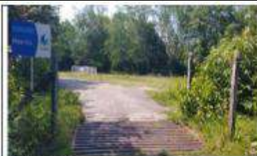
Fotografía 5. Lugar: Quiébralas vía Toldado 3 Fecha: Febrero de 2023 Observación: Quebra patas vía Toldado 3, libre de materiales sobrantes
