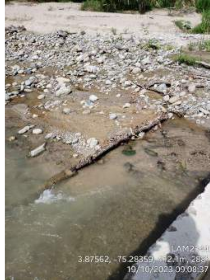
Fotografía 243. Cruce subfluvial del río Peralonso. Nótese la existencia de tubería de líneas de flujo abandonadas sobre el cauce del río. Coordenadas Origen Único Nacional – E: 4746506 N: 1986596.
