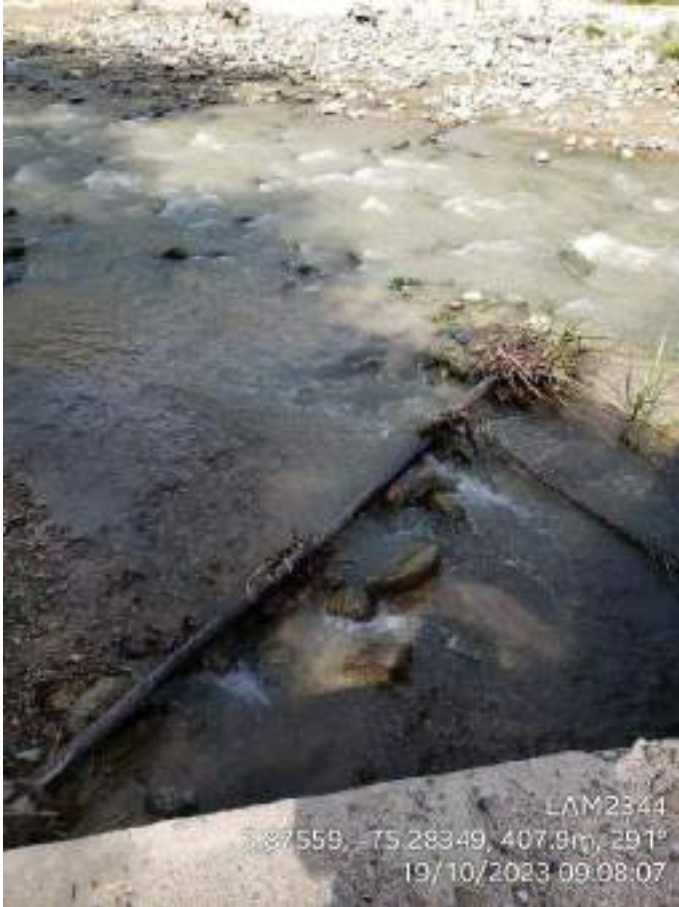
Fotografía 243. Cruce subfluvial del río Peralonso. Nótese la existencia de tubería de líneas de flujo abandonadas sobre el cauce del río. Coordenadas Origen Único Nacional – E: 4746506 N: 1986596.
