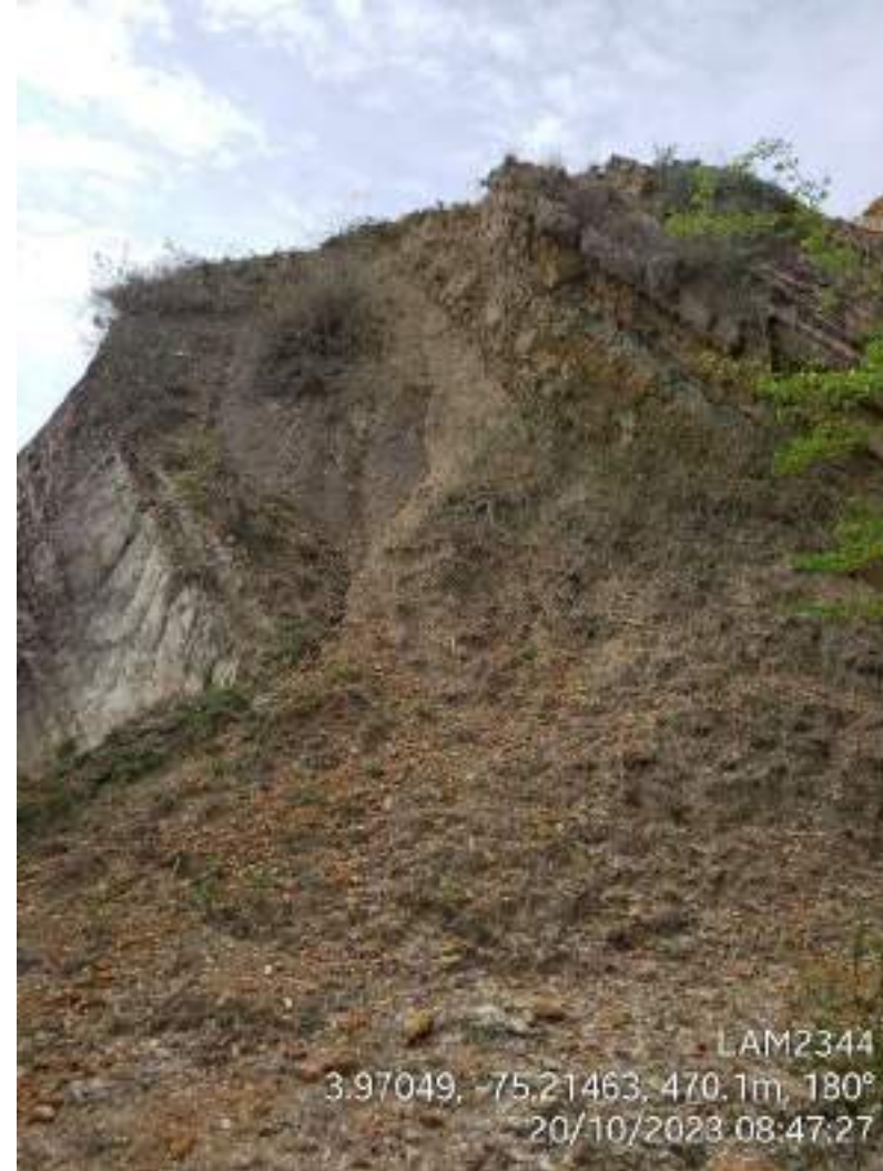
Fotografía 78. Vía de acceso plataforma Don Pedro CPI. Talud de corte con desprendimiento de material. Nótese la acumulación de fragmentos de roca y sedimentos en la pata del talud. Coordenadas Origen Único Nacional – E: 4754177 N: 1997064.
