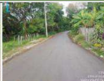
Fotografía 12. Lugar: Vía Campo Toy Fecha: Agosto de 2022 Observación: mantenimiento de vía con emulsión asfáltica
