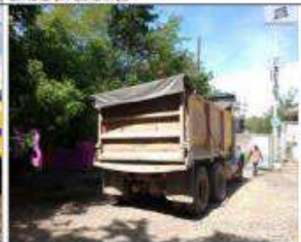
Fotografía 14. Lugar: Estación Toldado Fecha: Mayo 2022 Observación: Recubrimiento con geotextil los materiales de construcción durante el transporte al sitio de disposición.
