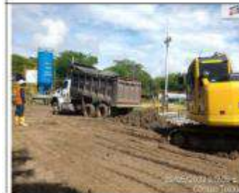
Fotografía 13. Lugar: Estación Toldado Fecha: Mayo 2022 Observación: Recubrimiento con geotextil los materiales de construcción durante el transporte al sitio de disposición.
