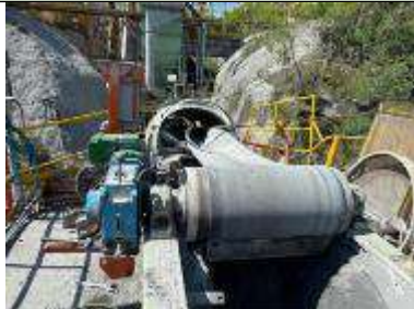
Fuente: ICA 27 \ Anexo 4.6.7 Mantenimientos de filtros de Mangas
