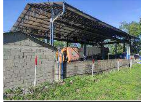
Fuente: Visita de control y seguimiento ambiental realizada del 25 al 27 de noviembre de 2024
