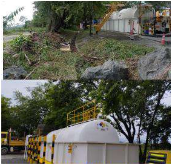
ILUSTRACIÓN 9. RETIRO DE MATERIAL ZONA COMBUSTIBLE.
