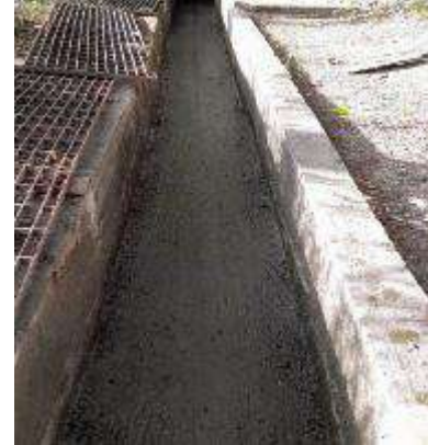
Fuente: ICA 27 \ Anexo 4.1.1 Mantenimiento de trampa de grasa \ C Registro Fotográfico
