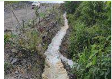
Fotografía. Instalación de trinchos en madera Expansión Escombrera Superior, funcional. Mina La Esmeralda. 4.296328N - 75.114682E WGS-84
