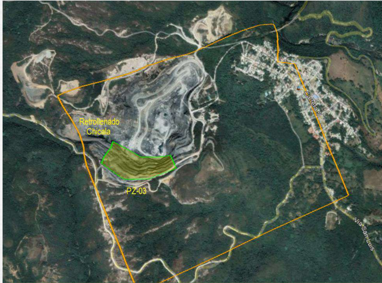
Figura. Talud final en frente Tajo Sur, sector entre el Retrolledado Chicalá y Piezómetro PZ-03. 4.290583N - 75.108466E WGS-84
