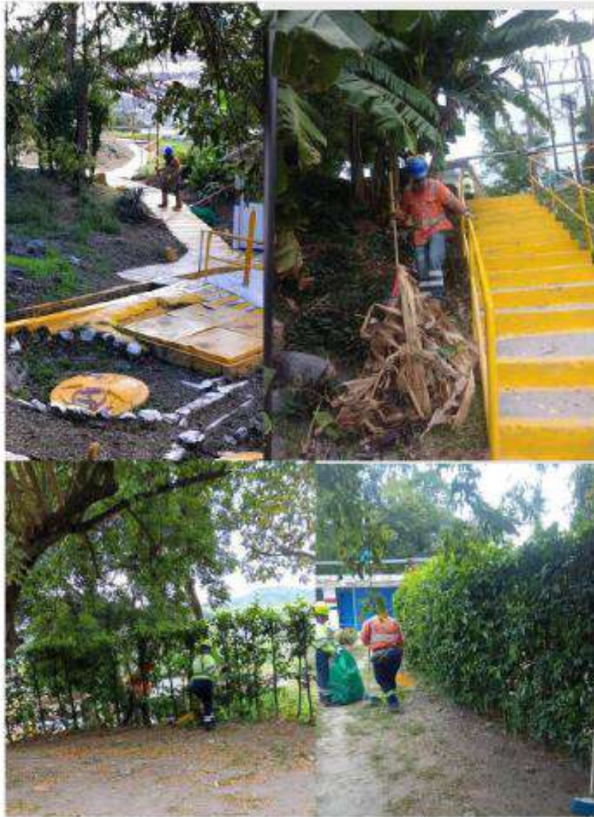
ILUSTRACIÓN B. AREA DE LA PTAR.
