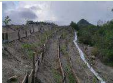
Fotografía. Instalación de trinchos en madera Expansión Escombrera Superior, funcional. Mina La Esmeralda. 4.296328N - 75.114682E WGS-84
