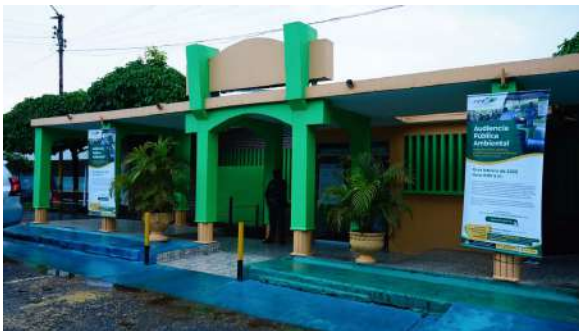
Fotografía No. 1. Club de Mares. Corregimiento el Centro - Vereda Campo 22 de Barrancabermeja
