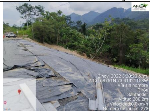
Fotografía 7. Contingencia de la unidad funcional 5 con obra hidráulica incompleta que puede saturar el terreno – posible afectación adicional de vegetación
