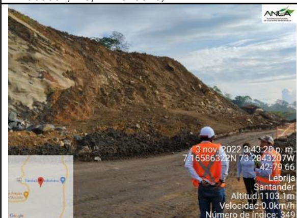
Fuente: Fuente: Equipo de Seguimiento Ambiental ANLA, fecha de toma de la fotografía 03-11-2022.
