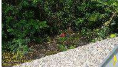
Foto 8 Material deslizado por terraplén (Coordenadas planas origen único 4966705.565E, 2349823.951N)
