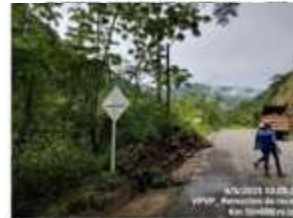
Fecha: 06 mayo de 2025 Sitio: km 10+600 Atención a observación: Cargue de material de roca fragmentada
