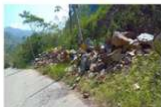
Fecha: 29 febrero de 2024 Sitio: km 10 Observación: Rocas al lado (sitio identificado) km 10+260
