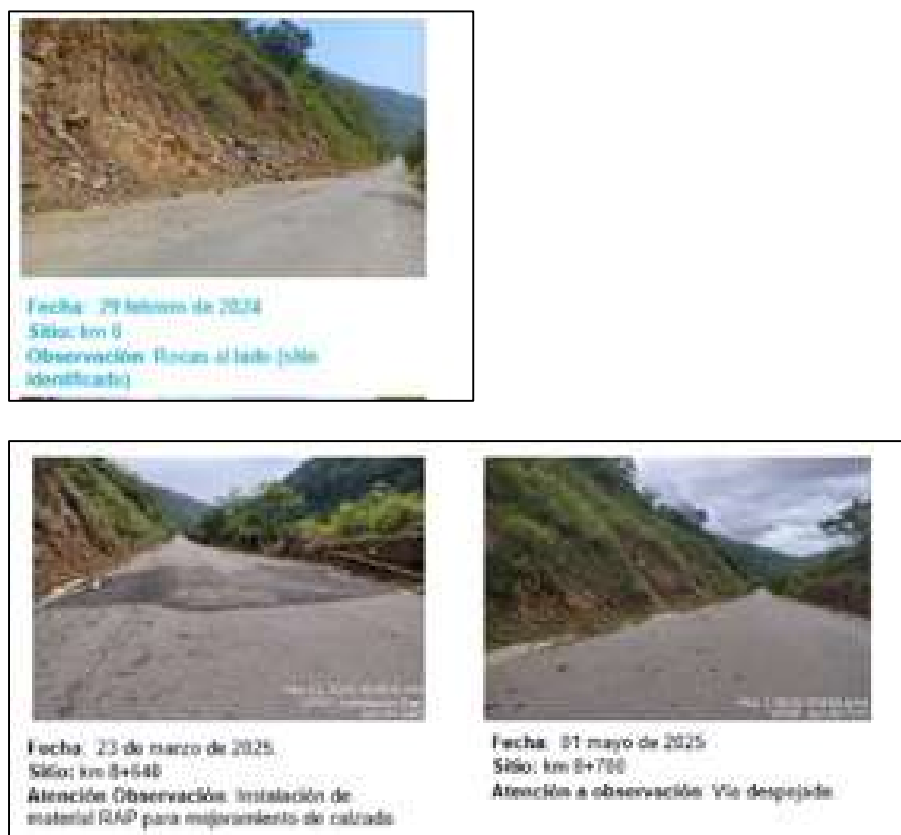
Figura 17. Comparativo del sector del Km 8 +00 de la vía Puerto Valdivia Presa entre febrero de 2024 y mayo de 2025
