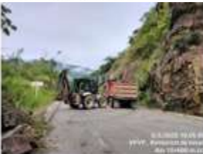
Fecha: 06 mayo de 2025 Sitio: km 10+600 Atención a observación: Cargue de material de roca fragmentada
