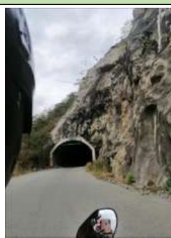
Fotografía 130. FOTO 2024-02-06 FALTA DE ILUMINACIÓN Y SEÑALIZACIÓN EN TÚNELES 1
