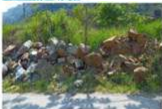
Fecha: 29 febrero de 2024 Sitio: km 10 Observación: Rocas al lado (sitio identificado) km 10+600
