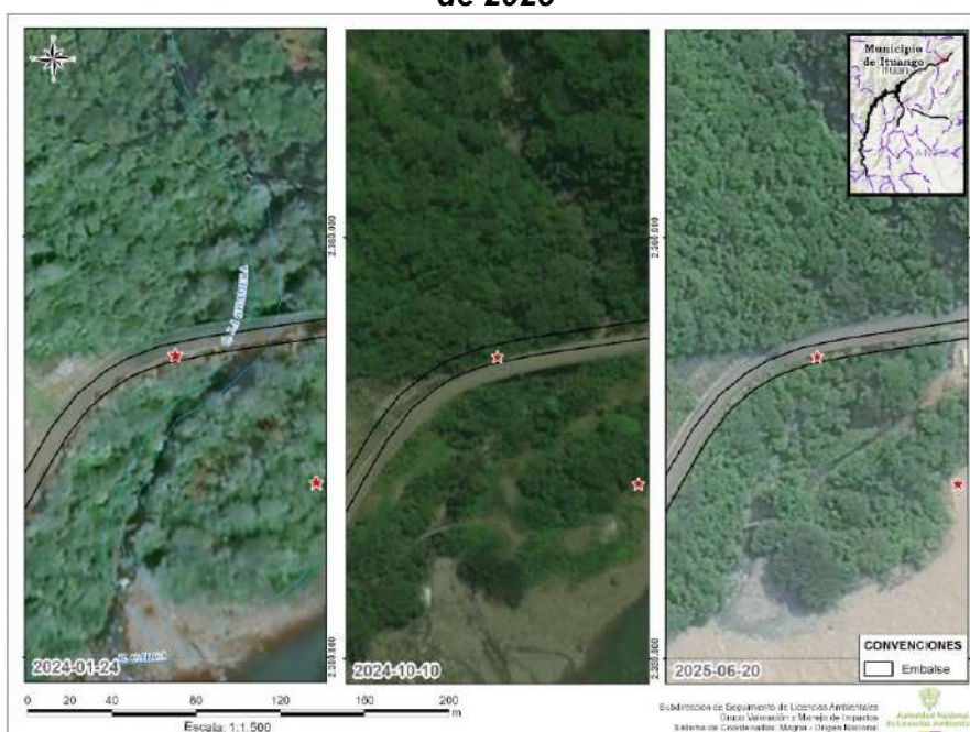
Figura 18. Km 8 Vía Puerto valdivia Presa en enero de 2024, octubre de 2024 y junio de 2025
