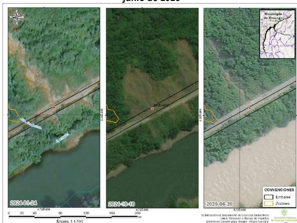
Figura 35. Km 8+640 Vía Puerto valdivia Presa en enero de 2024, octubre de 2024 y junio de 2025
