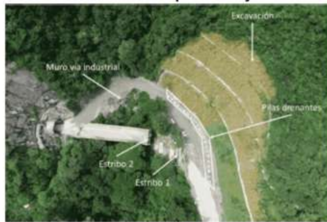
Figura 186 Panorámica sector puente 57 y obras asociadas
