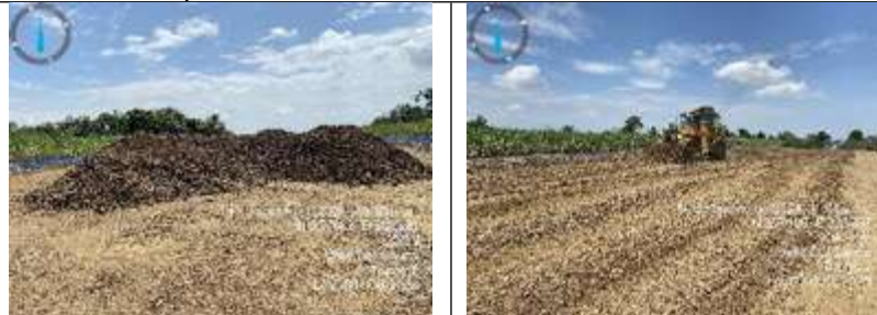
Incorporación de material roca muerta Tramo 2
