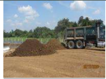
Fuente: Equipo de Seguimiento Ambiental ANLA, fecha de toma de la fotografía 05/12/2023
