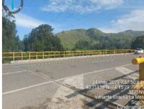
Fotografía 2. Puente existente sobre Río Bogotá sector Alicachín
