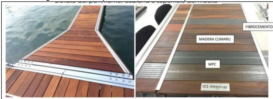
Imagen 6 Detalle del pavimento, cubierta o superficie del muelle
