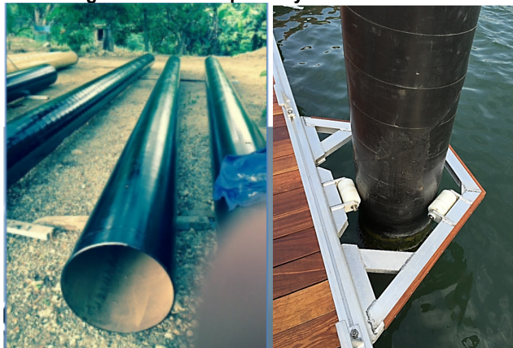
Imagen 9 Detalle de pilotes y anillas deslizantes
