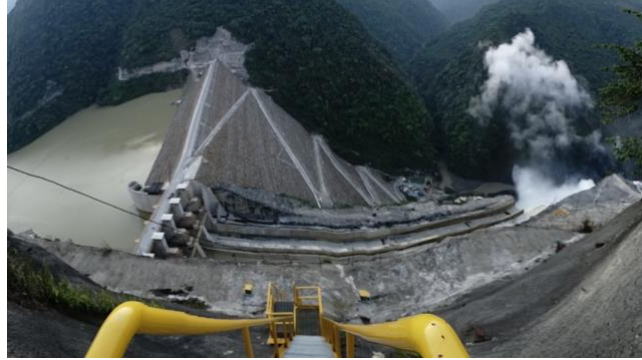
Imagen 1. Vista de la presa, vertedero y embalse. Proyecto Hidroeléctrico Pescadero Ituango
