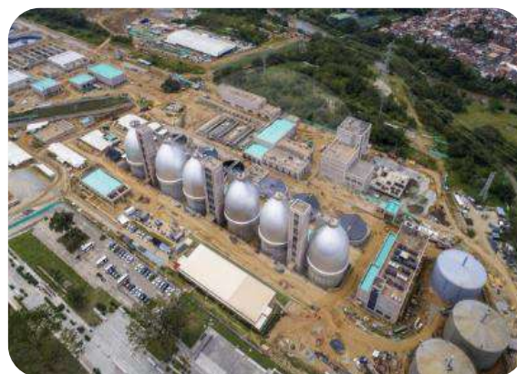
Plantas de tratamiento de agua residual – PTARs
