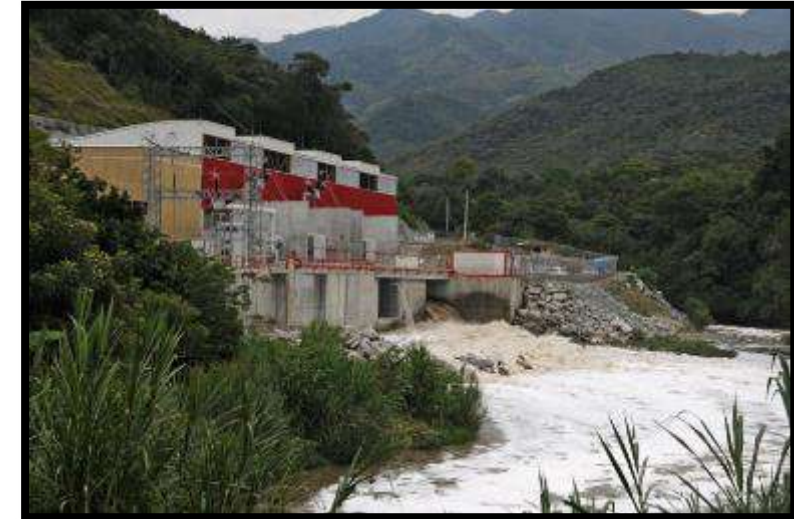
HIDROELECTRICA CARLOS LLERAS
