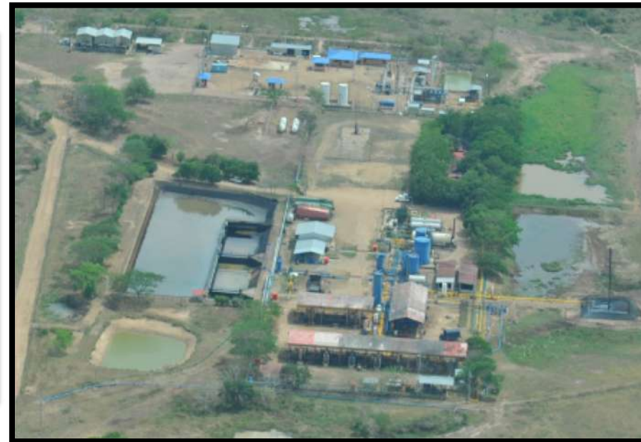
ESTACIÓN LA GLORIA (Aguazul-Casanare) PLANTA DE APROVECHAMIENTO GN EN CAMPO PETROLERO PARA AUTOGENERACIÓN
