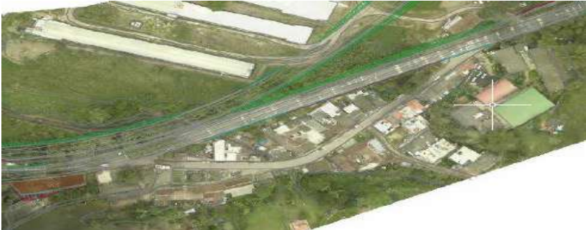
Figura 10 Acceso Corregimiento Portugal – UF9
