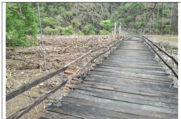
Fotografía 1. Palizada en el Puente de Llanos de Niquia
