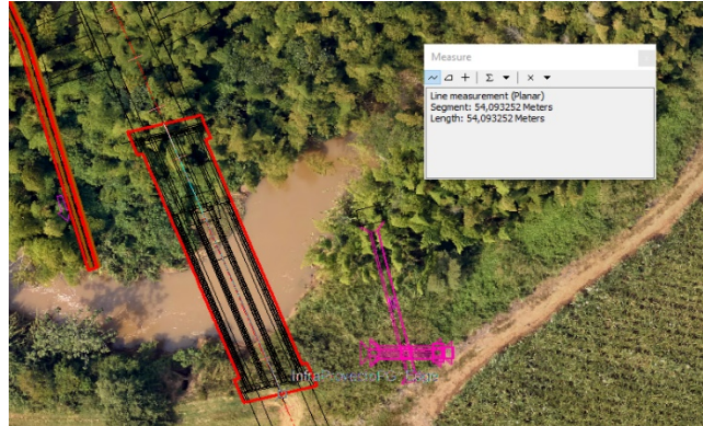
Figura 2. Puente Río Jamundi
