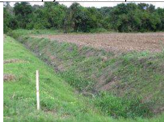
Fotografía 44 K10+570 – Canal de riego de caña. Se proyecta alcantarilla simple.
