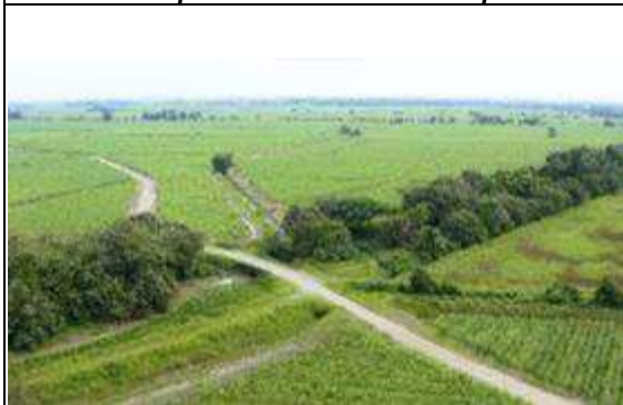
Fotografía 15 Panorámica del área para el Puente Vehicular sobre Zanjón Potrerillo. Se observa puente existente a reemplazar.
