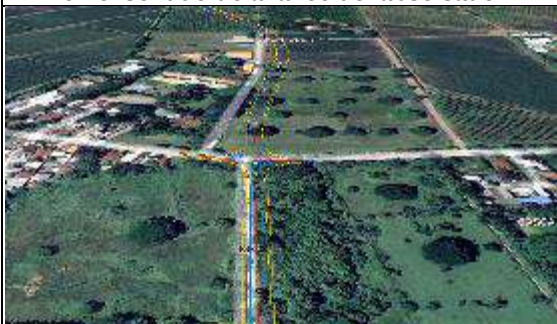
Fotografía 21 Vista de la configuración geométrica de la Intersección con Carrera 143 en el sentido de avance del abscisado.
