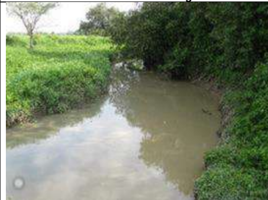
Fotografía 16 El puente se proyecta sobre el zanjón potrerillo y sobre el canal paralelo existente en el área sin vegetación.
