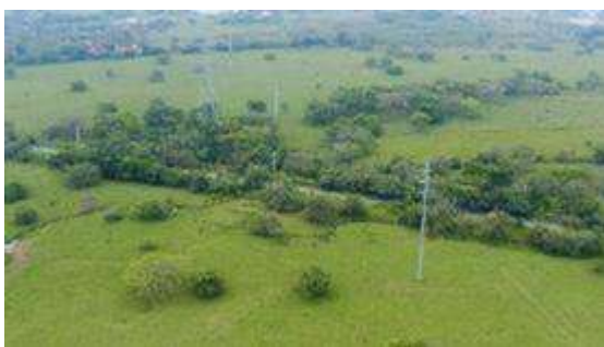
Fotografía 11 Panorámica del área para el puente Vehicular sobre Intersección Cali – Puerto Tejada.
