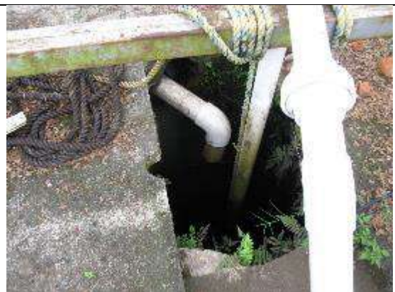
Fotografía 58 El aljibe se encuentra funcional y se utiliza para riego de cultivo de limón.
