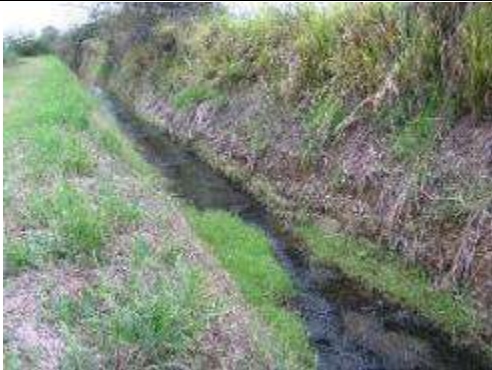
Fotografía 39 K6+610 - Acequia El Asombro. Se proyecta Box Culvert grande.
