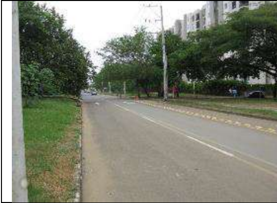
Fotografía 34 El puente se construirá en frente de zona de edificios sobre las calzadas existentes y la proyectada.
