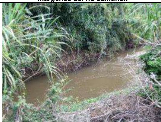
Fotografía 14 El puente requiere la intervención de parte de la vegetación presente en las márgenes del río Jamundí.
