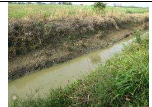
Fotografía 28 La intersección intervendrá el canal paralelo a la vía que conduce hacia Bocas del Palo.
