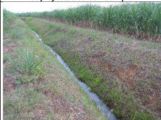
Fotografía 43 K6+145 – Canal de riego de caña. Se proyecta alcantarilla simple.
