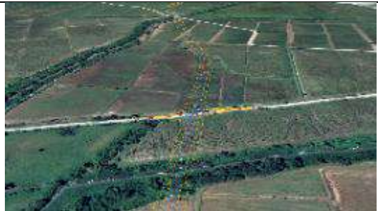
Fotografía 25 Vista de la configuración geométrica de la Intersección Bocas del Palo en el sentido de avance del abscisado.
