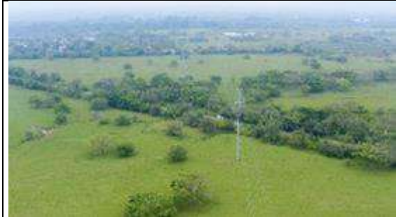
Fotografía 18 Panorámica del área a intervenir por la Intersección Cali – Puerto Tejada en el sentido de avance del abscisado.
