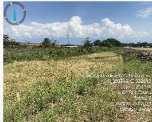
Revegetalización de espaldones
