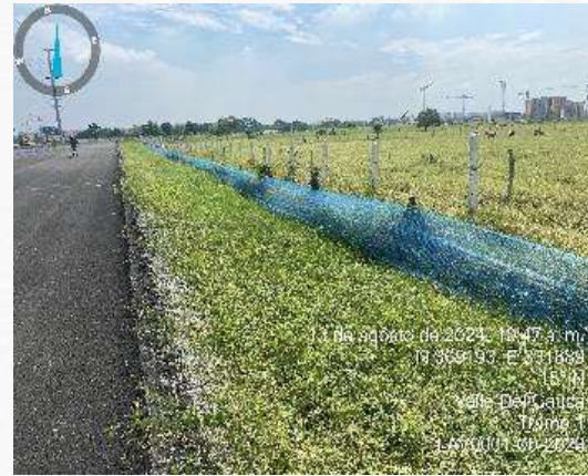
Conformación de terraplenes Tramo 1
