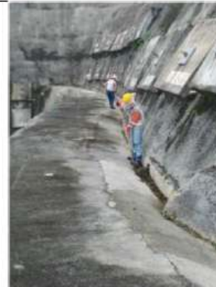
Localización: Portal Entrada Observación: Limpieza cunetas en bermas
