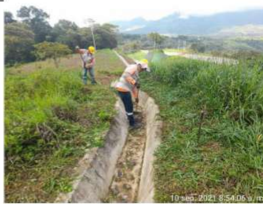
Localización: Portal Salida Observación: Limpieza cunetas y zanjas de coronación
