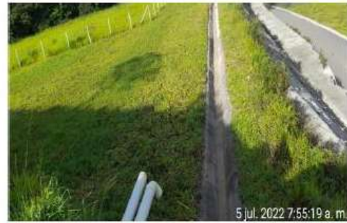
Localización: Talud Portal Salida Observación: Limpieza cunetas y zanjas de coronación
