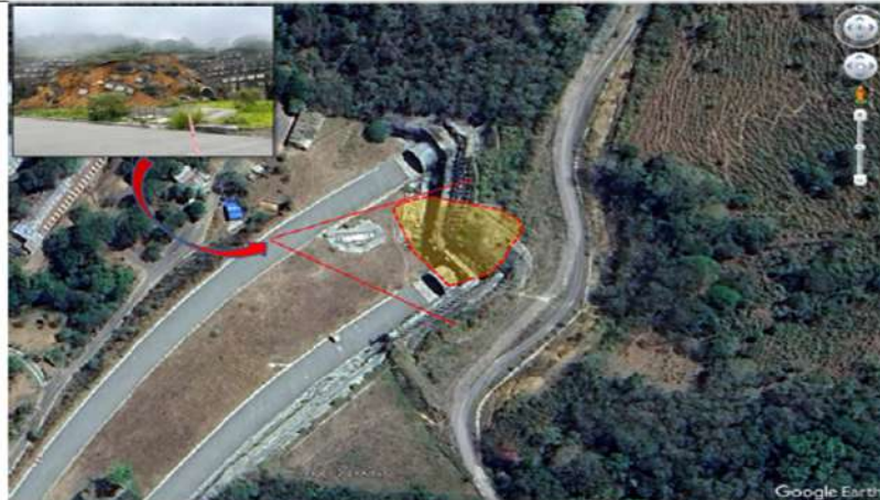
Descripción: Fotografía aérea donde se marca la magnitud del deslizamiento. Fecha: 19 de mayo del 2024.
