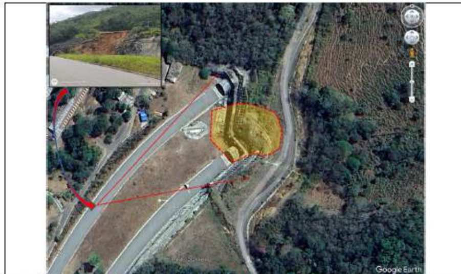
Descripción: Fotografía aérea donde se marca la magnitud del deslizamiento que ha sido progresivo con el paso de los días. Fecha: 21 de mayo del 2024.
