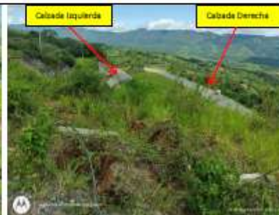
Descripción: Parte superior del portal salida, sobre la calzada izquierda. Fecha: 28 de mayo del 2024
