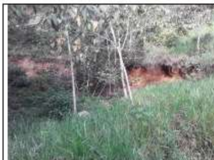
Descripción: En la parte alta de la montaña posterior del portal Salida del Túnel 8 se evidencia un corte (hundimiento) del suelo aproximado de 1 metro que posiblemente genero el desplazamiento del material hacia la parte baja (portal Salida). Fecha: 06 de junio 2024
