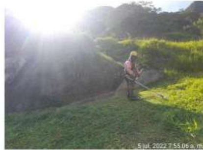
Localización: Talud Portal Salida Observación: Se realiza rocería
