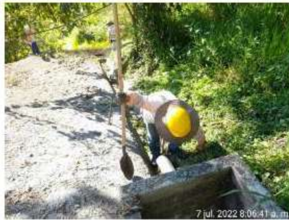
Localización: Talud Portal Salida Observación: Limpieza cunetas y zanjas de coronación
