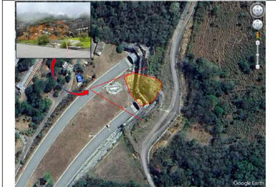
Descripción: Fotografía aérea donde se marca la magnitud del deslizamiento. Fecha: 19 de mayo del 2024.
