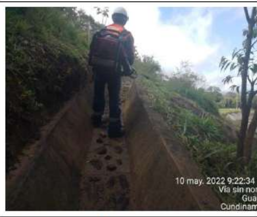
Localización: Portal Salida Observación: Limpieza cunetas y zanjas de coronación
