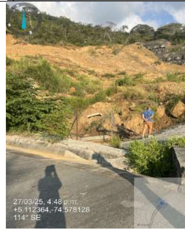
Fuente: ESA – ANLA. Fecha de toma de la fotografía 27/03/2025
