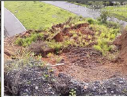
Descripción: Vista de la parte alta del talud portal Salida – túnel 8. Fecha: 06 de junio 2024
