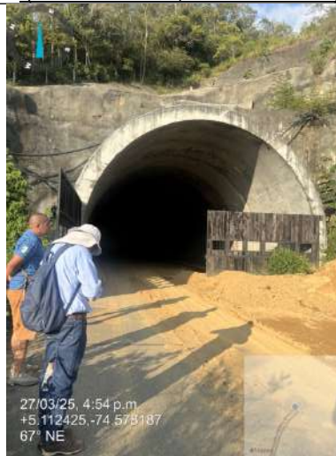
Fuente: ESA – ANLA. Fecha de toma de la fotografía 27/03/2025
