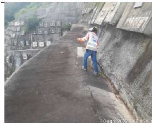
Localización: Portal Salida Observación: Limpieza cunetas y zanjas de coronación
