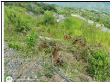
Descripción: Parte superior del portal salida, sobre la calzada izquierda. Fecha: 28 de mayo del 2024
