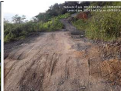
Descripción: vía veredal de San Miguel, se evidencia el movimiento del terreno, se continua con el transito vehicular por el sector. Fecha: 06 de junio 2024
