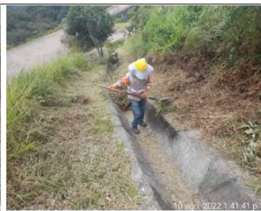
Localización: Portal Entrada Observación: Limpieza cunetas y zanjas de coronación
