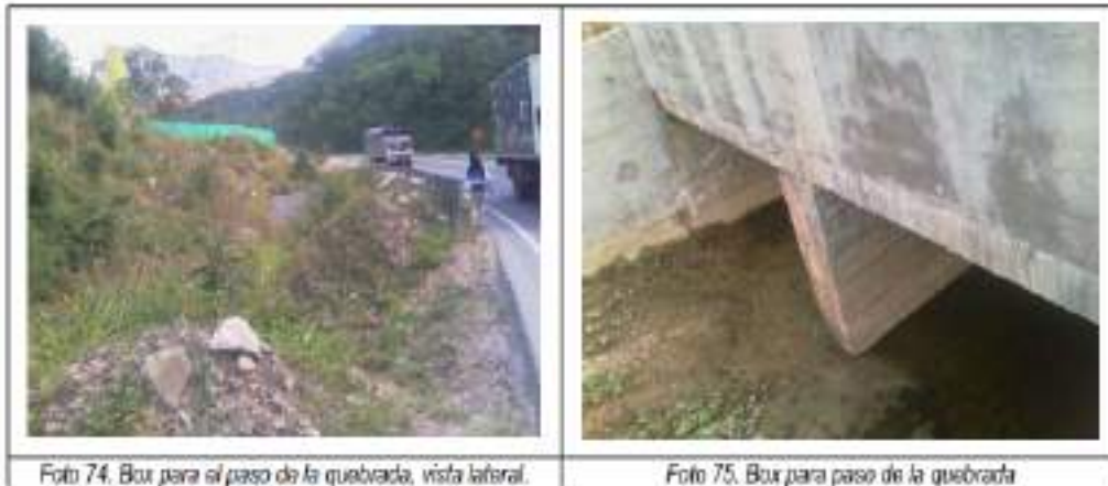
Foto 74. Box para el paso de la quebrada, vista lateral.
