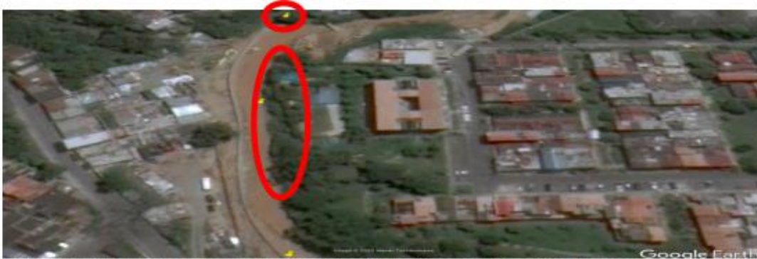
Fotografía 5. Tramo 3- paralelo a la carrera 66d entre calle 64 a y 63, Fecha: mayo de 2017 Fuente: Google Earth y Concepto técnico 02359 del 23 de mayo de 2019. POC0073-00
