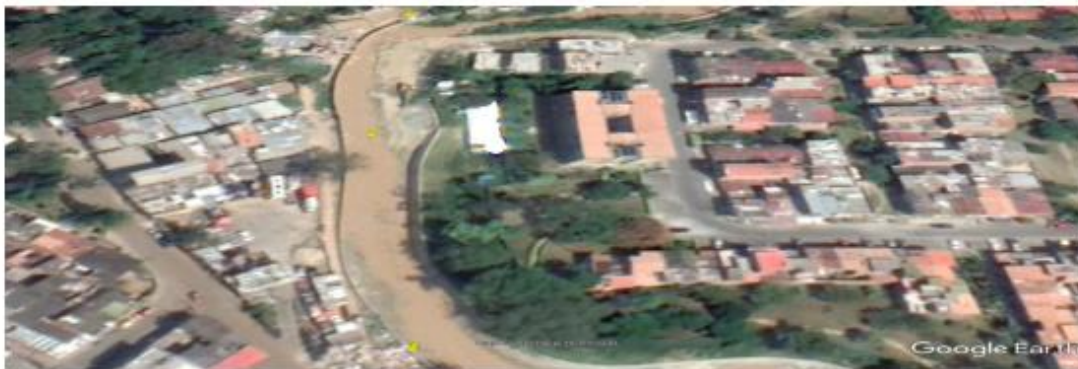
Fotografía 6. Tramo 3- paralelo a la carrera 66d entre calle 64 a y 63, Fecha: enero de 2019 Fuente: Google Earth y Concepto técnico 02359 del 23 de mayo de 2019. POC0073-00
