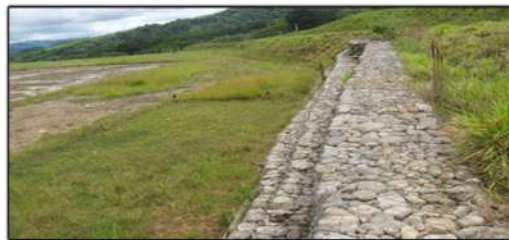
Visita talud realizado el 13 de Marzo de 2019 continua talud en reposo no sufrió desplazamiento está al borde del canal perimetral
