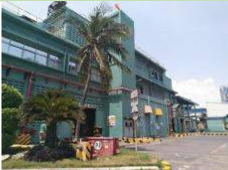
Fotografía 14. Bahía de estacionamiento
