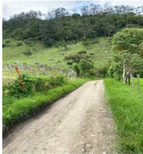
Fotografía 7 Área acceso Acc-PT2
