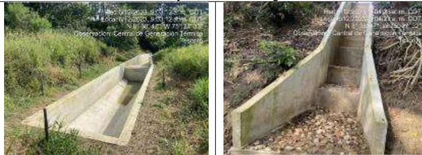
Sedimentador y canal de descarga 3 – OC3
