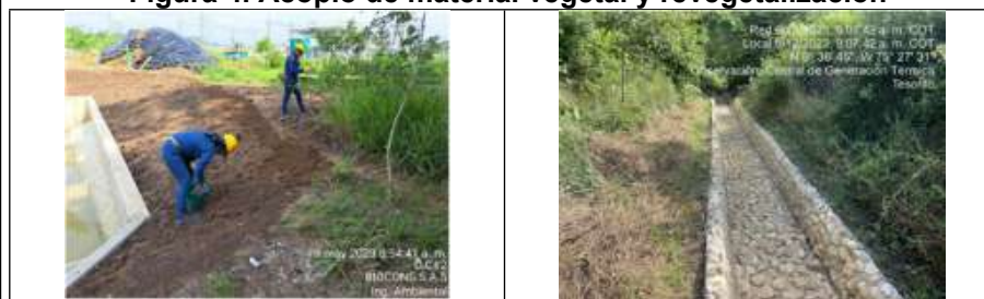
Figura 4. Acopio de material vegetal y revegetalización
