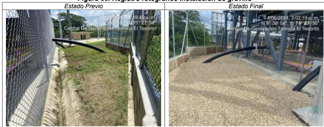
Figura 60. Registro fotográfico instalación de gravilla
