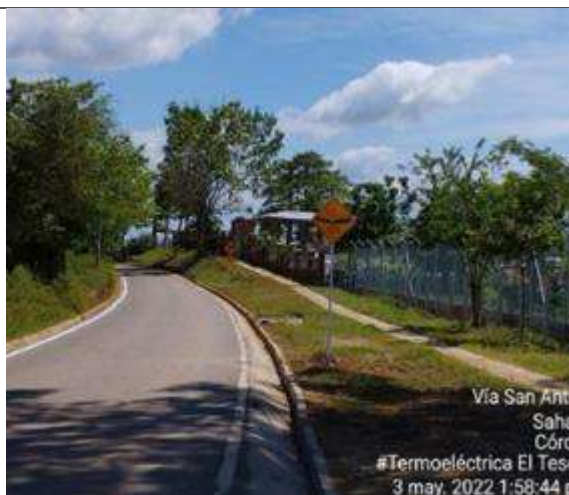
Fotografía: No 13 SOC_07 Fecha: 03 mayo 2022 Lugar: Vía principal de San Antonio Coordenadas: N/A Observación: PMA_SOC_07 Señalización Vial – Riesgo de accidente
