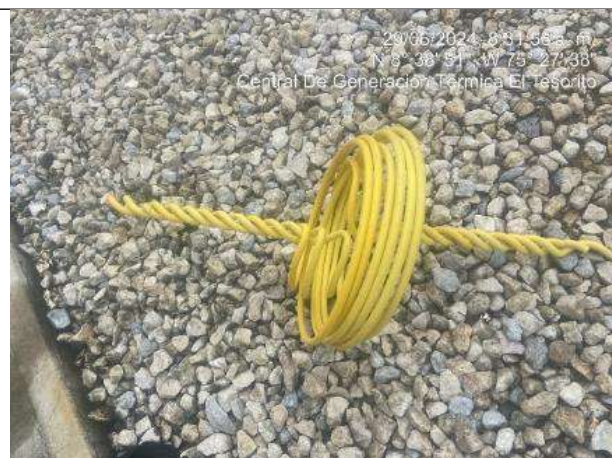
Fotografía 2. Tipo de desviadores instalados
