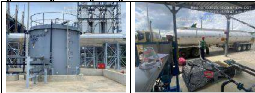
Figura 20. Registro fotográfico gestión de lodos en la central térmica
