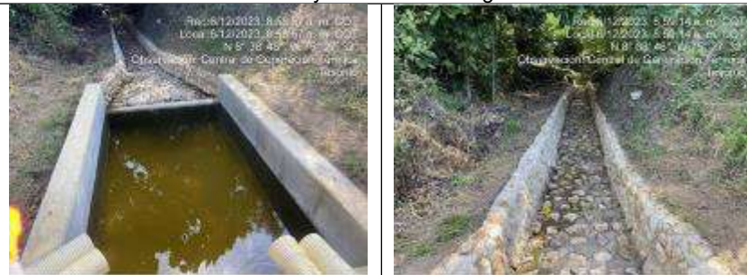
Sedimentador y canal de descarga 5 – OC5
