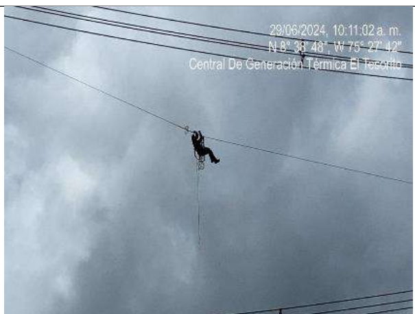
Fotografía 3 Proceso de instalación
