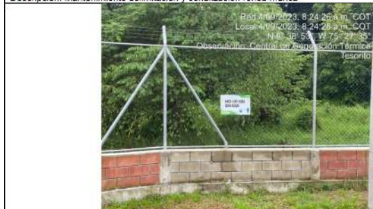
Fotografía No: 66 Fecha: 4-09-2023 Ubicación: Sedimentador 5 Descripción: Señalización y cerramiento ronda hídrica
