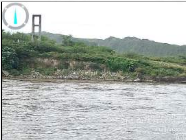
Vista general de la rampa de acceso y del gavión
