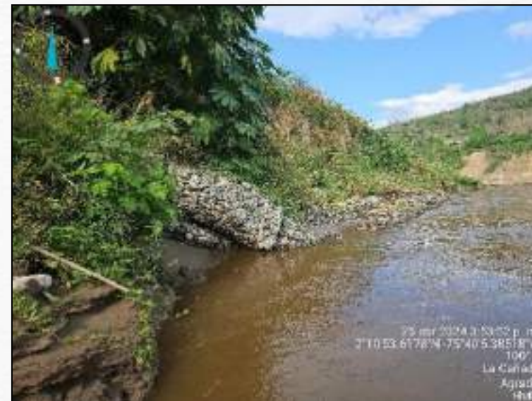
Vista lateral del gavión desde el embalse
